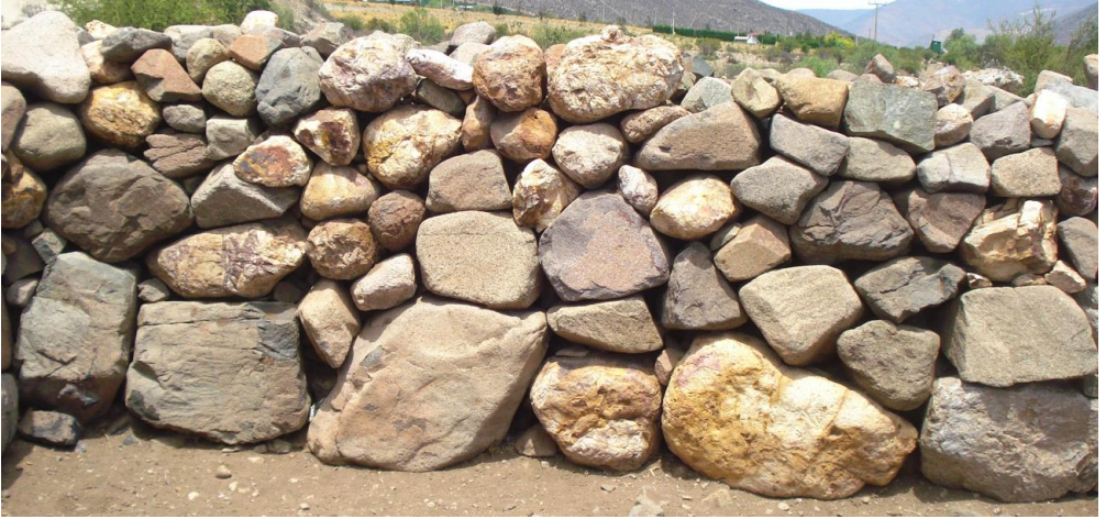
Fotografías: Diferentes estrategias constructivas para estructurar las esquinas de las pirkas (Tonci Tomic, 2012).
