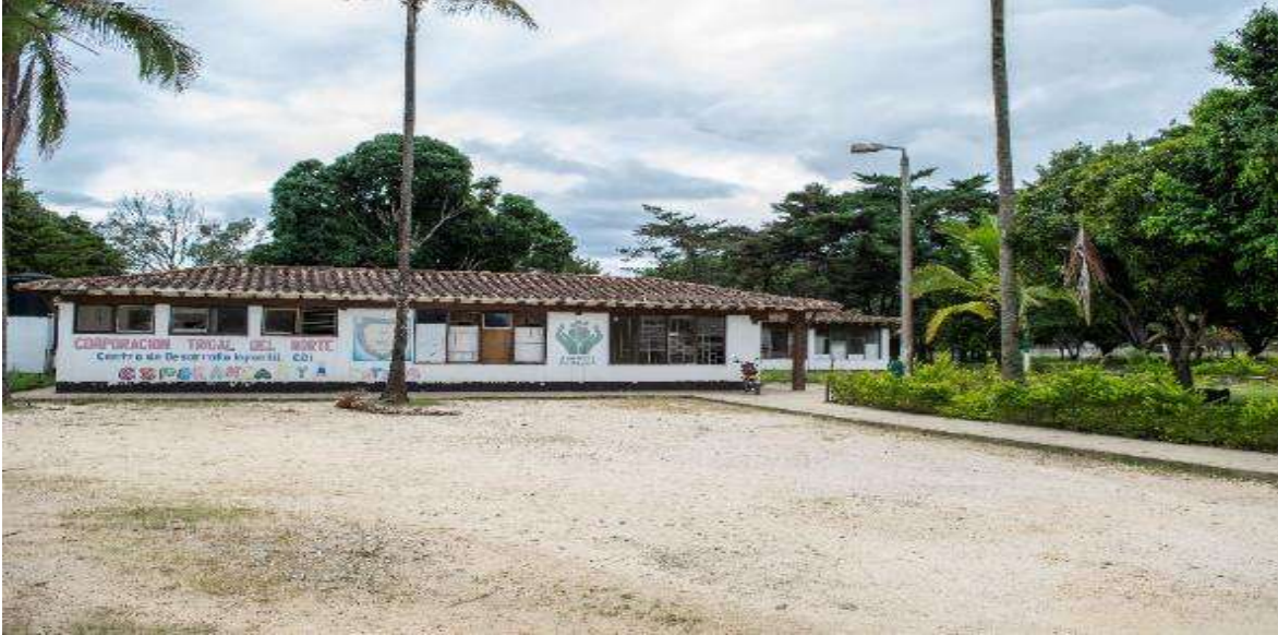
Fotografía 3 Instalaciones de ASUDRA
