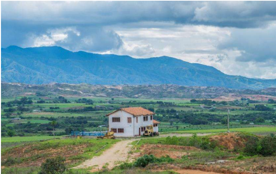
Fotografía 12 Panorámica Acueducto Municipal - Vereda Santa Lucía
