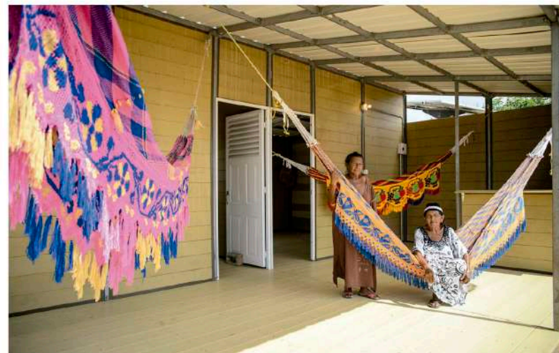
Vivienda rural dispersa. 685 casas de 44m 2 alta Guajira. Ola invernal - Comfaguajira, Fondo Adaptación
