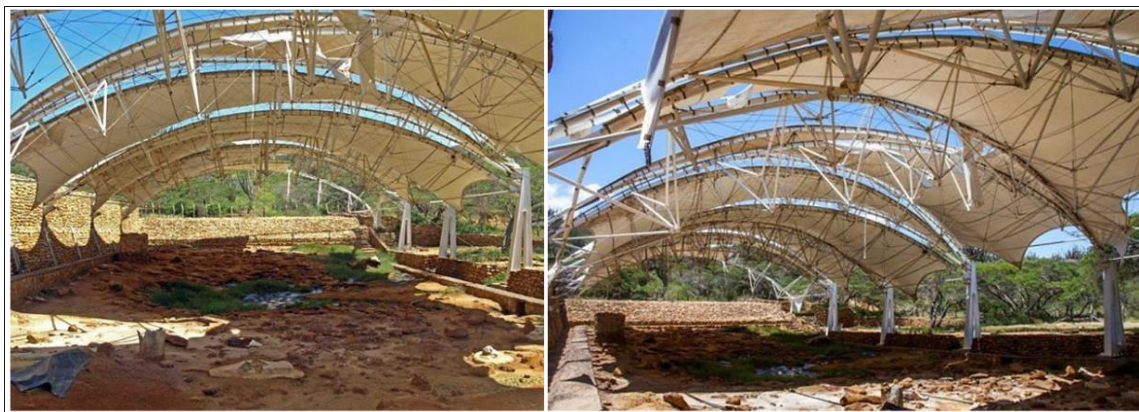
Figura 31. Estado de la cubierta protectora del sitio arqueológico Taima-Taima para 2017. Fuente: https://iamvenezuela.com/2017/09/desvalijan-el-museo-arqueologico-taima-taima/ (consulta: 13 de abril de 2019).
