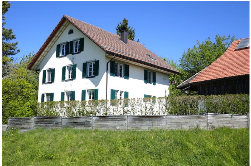
Ansicht von Süden (Bild SKW)
