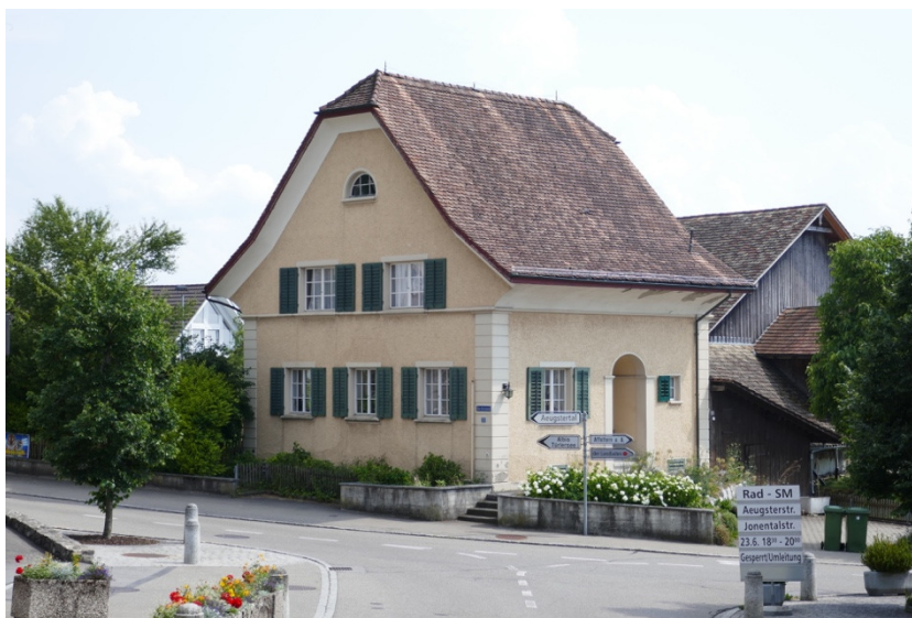
Ansicht von Norden (Bild SKW)
