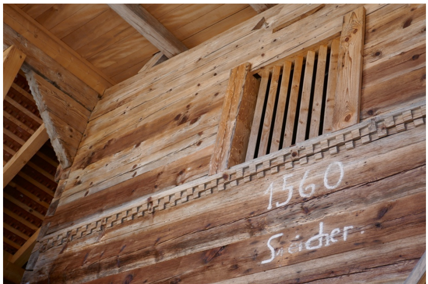
Ansicht Fassadendetail (Bild SKW)
