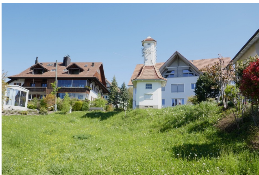
Ansicht von Süden (Bild SKW)
