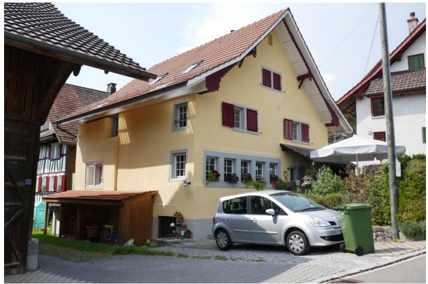
Ansicht von Südosten (Bild SKW)
