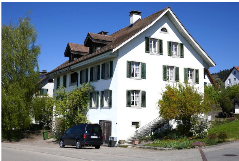
Ansicht von Südosten (Bild SKW)
