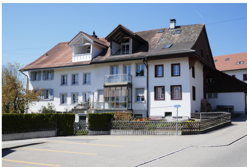
Ansicht von Osten (Bild SKW)
