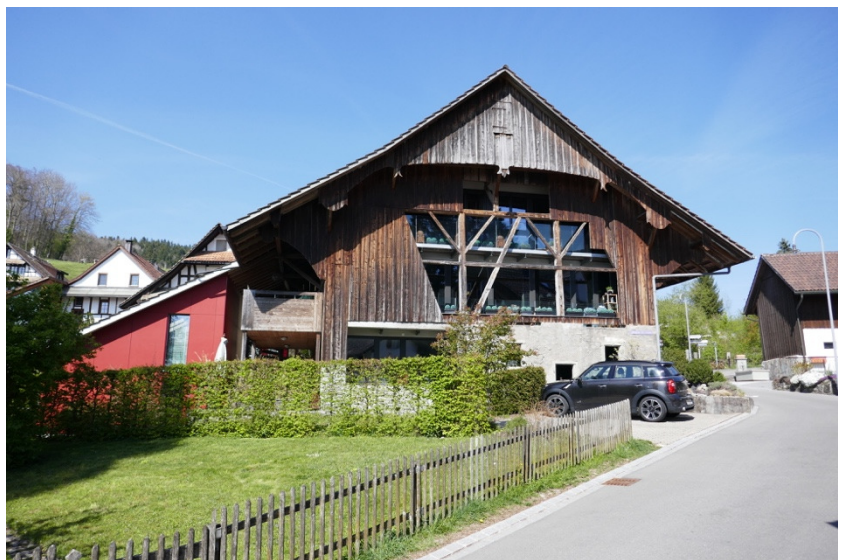
Ansicht von Süden (Bild SKW)
