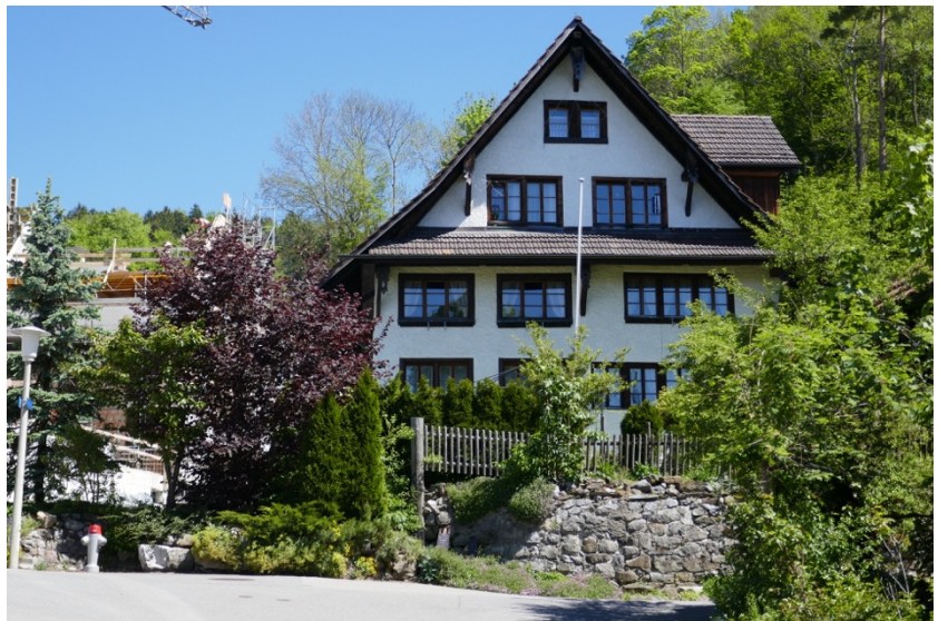
Ansicht von Süden (Bild SKW)
