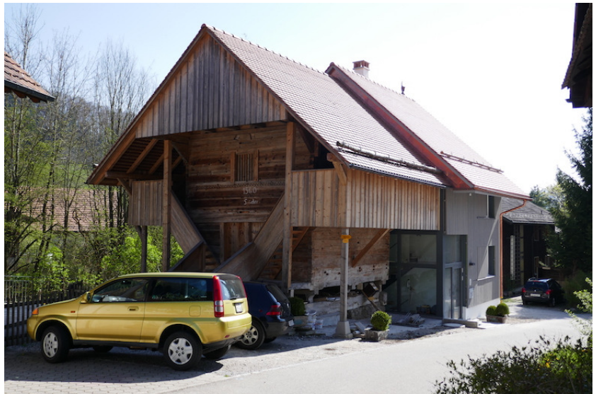
Ansicht von Norden (Bild SKW)
