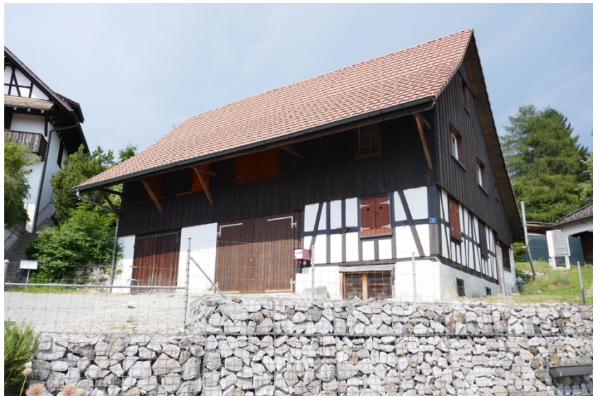
Ansicht von Südosten (Bild SKW)
