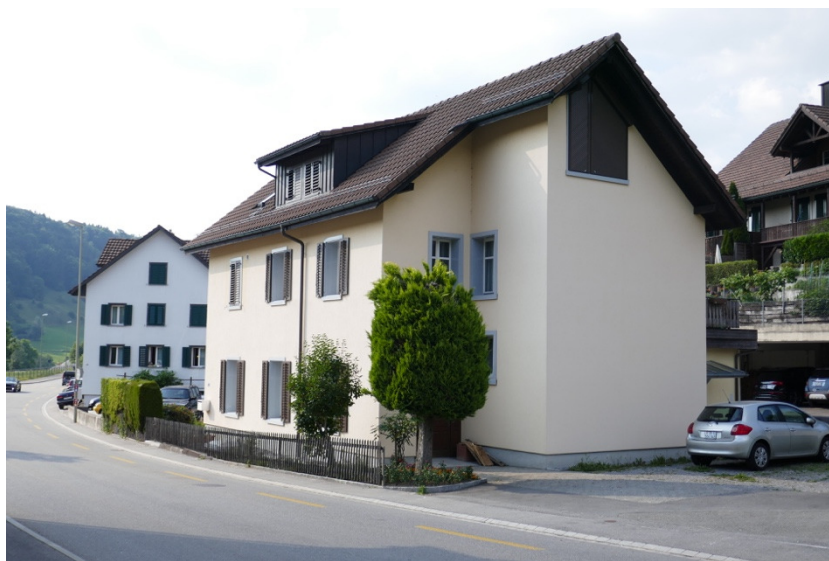
Ansicht von Süden (Bild SKW)
