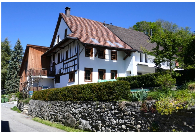
Ansicht von Südosten (Bild SKW)
