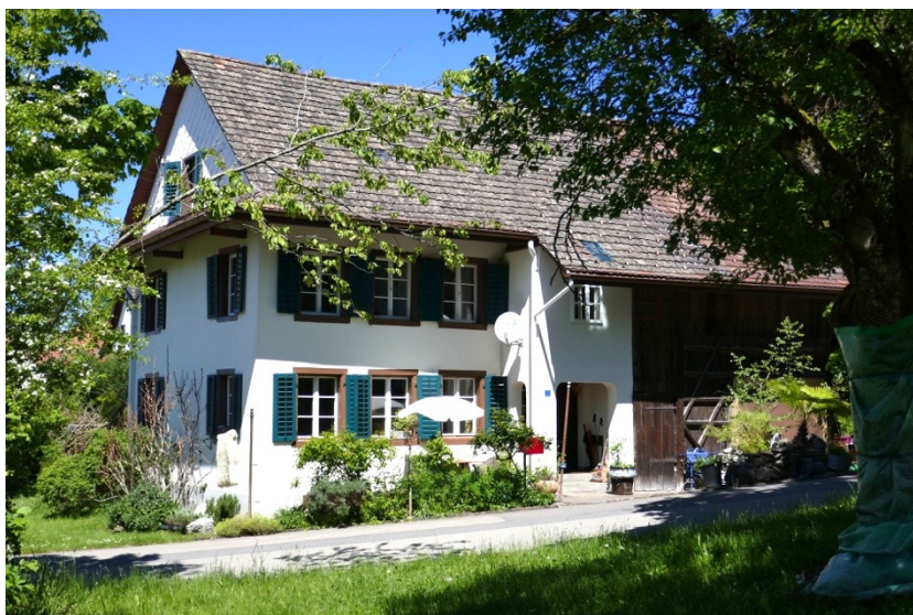
Ansicht von Südosten (Bild SKW)
