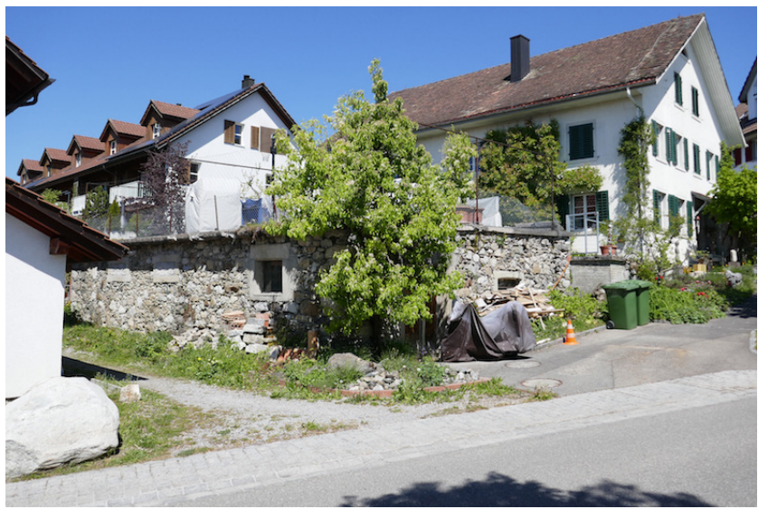
Ansicht von Süden (Bild SKW)
