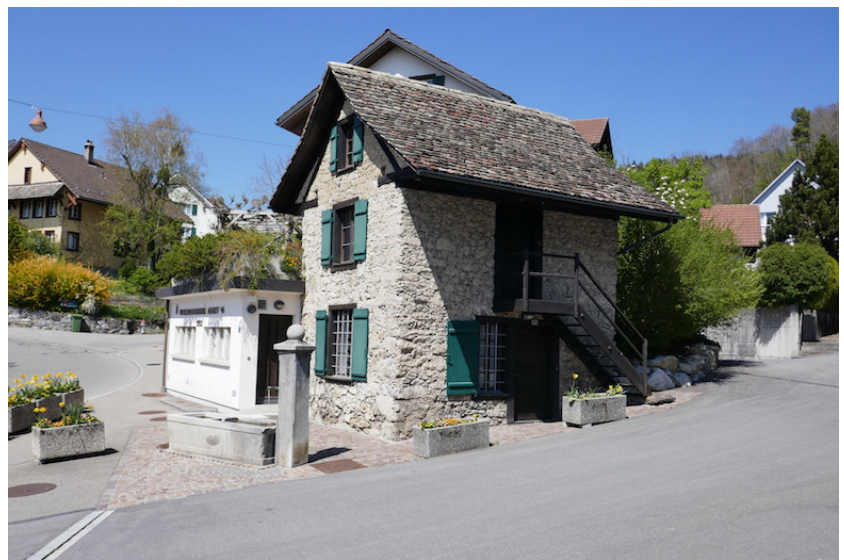
Ansicht von Süden (Bild SKW)
