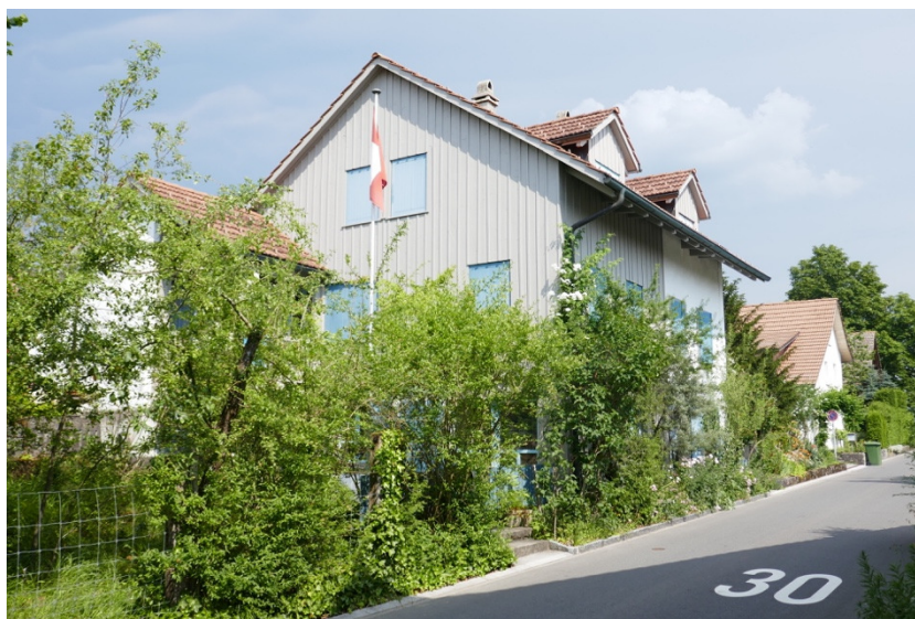
Ansicht von Südosten (Bild SKW)
