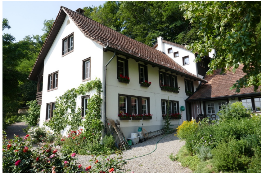
Ansicht von Süden (Bild SKW)
