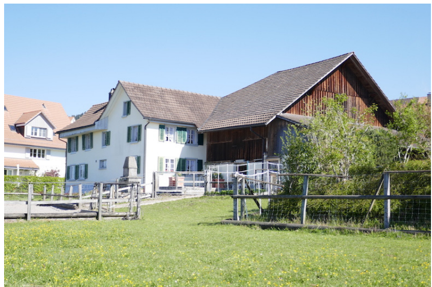
Ansicht von Süden (Bild SKW)
