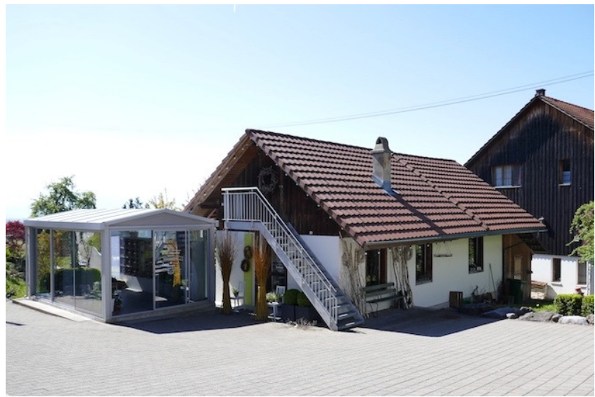
Ansicht von Norden (Bild SKW)
