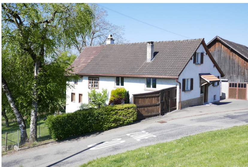
Ansicht von Osten (Bild SKW)
