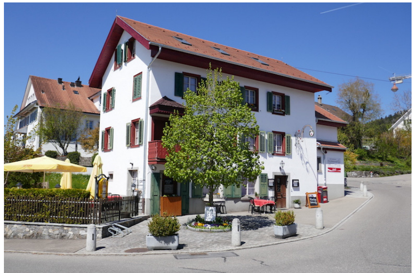
Ansicht von Südosten (Bild SKW)
