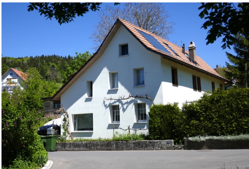
Ansicht von Süden (Bild SKW)
