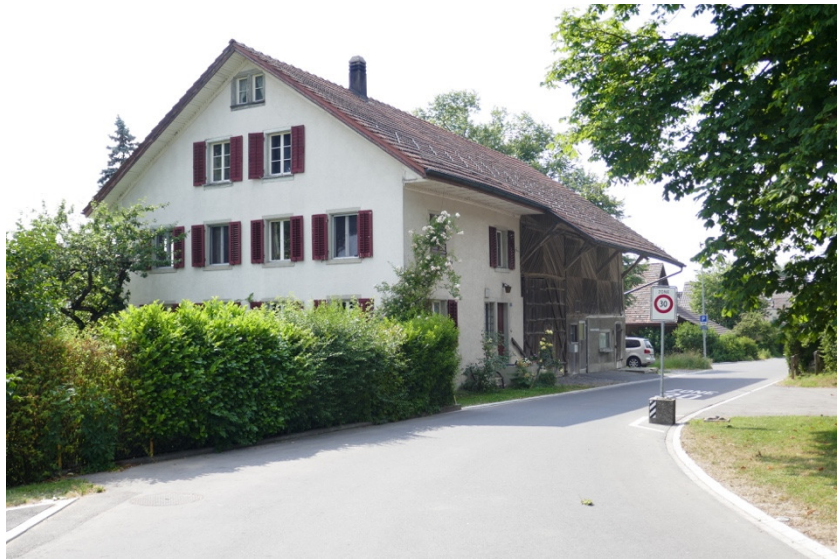
Ansicht von Südosten (Bild SKW)
