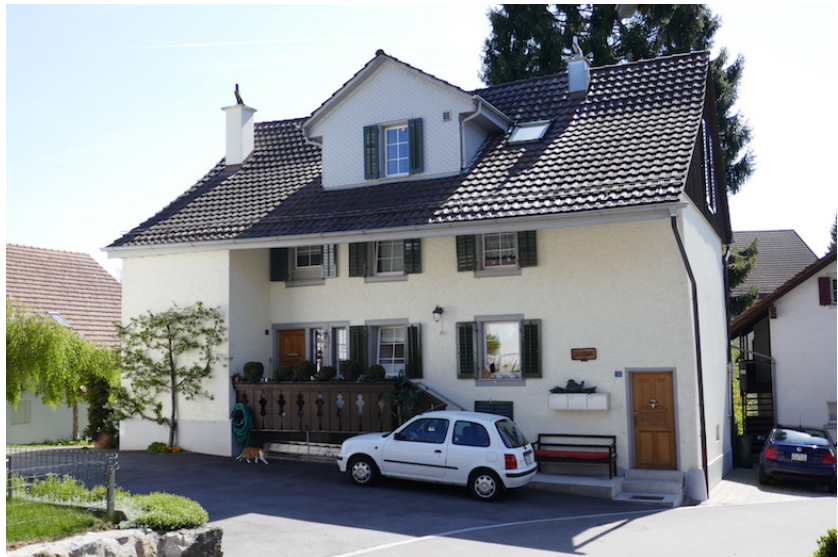
Ansicht von Norden (Bild SKW)
