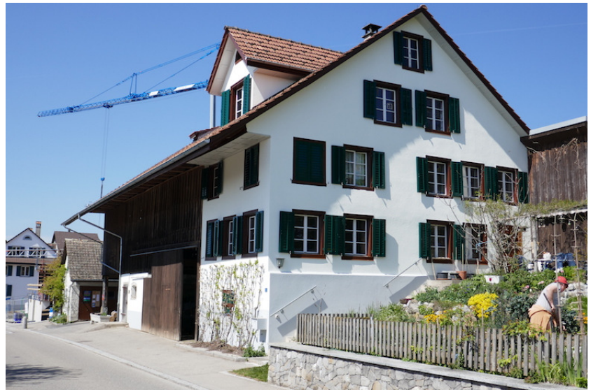
Ansicht von Südosten (Bild SKW)
