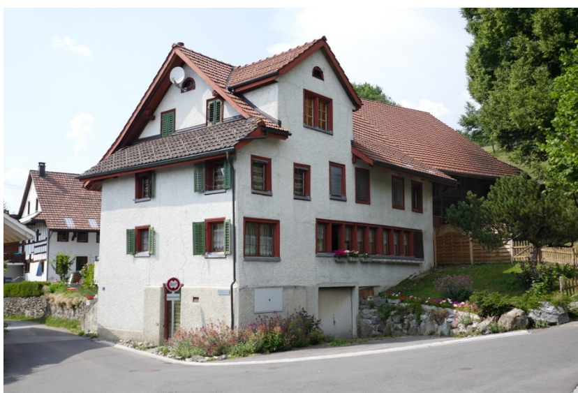
Ansicht von Süden (Bild SKW)
