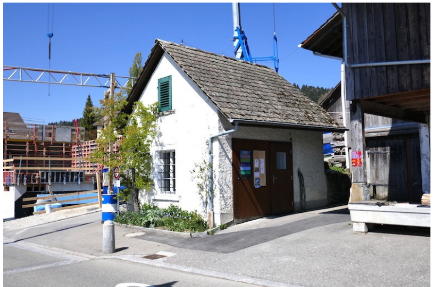
Ansicht von Süden (Bild SKW)
