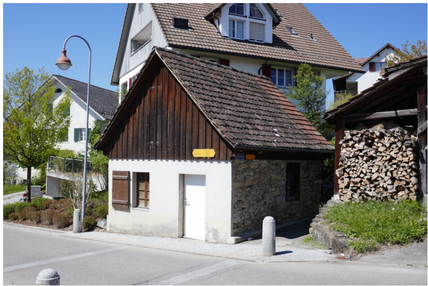
Ansicht von Osten (Bild SKW)
