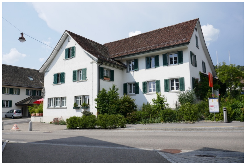
Ansicht von Süden (Bild SKW)
