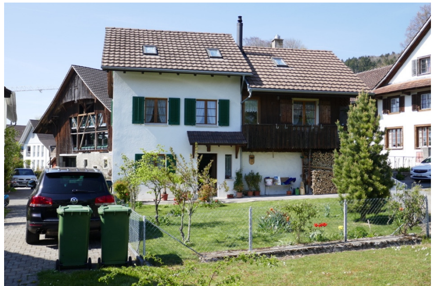
Ansicht von Südosten (Bild SKW)
