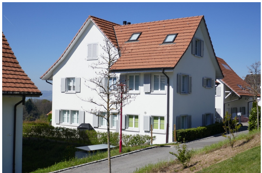
Ansicht von Osten (Bild SKW)
