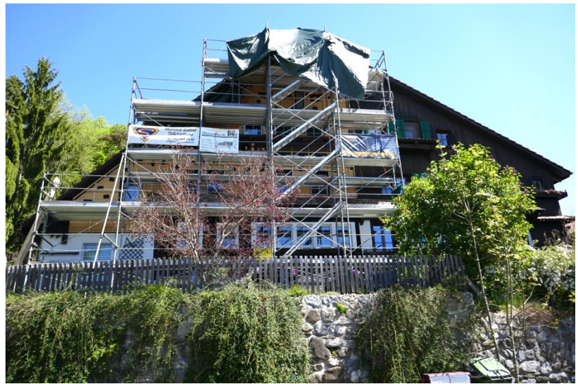
Ansicht von Süden (Bild SKW)
