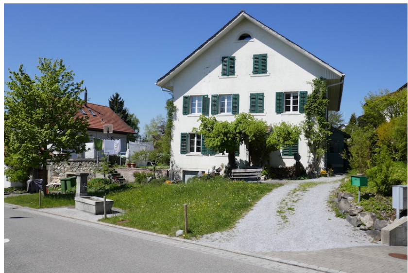
Ansicht von Osten (Bild SKW)
