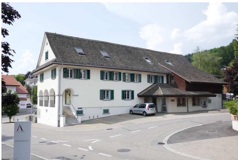
Ansicht von Südosten (Bild SKW)
