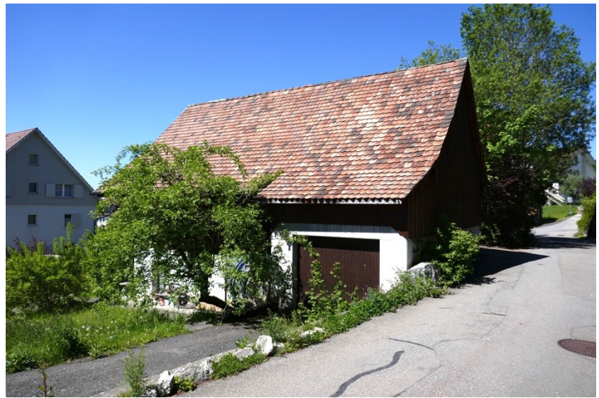
Ansicht von Süden (Bild SKW)
