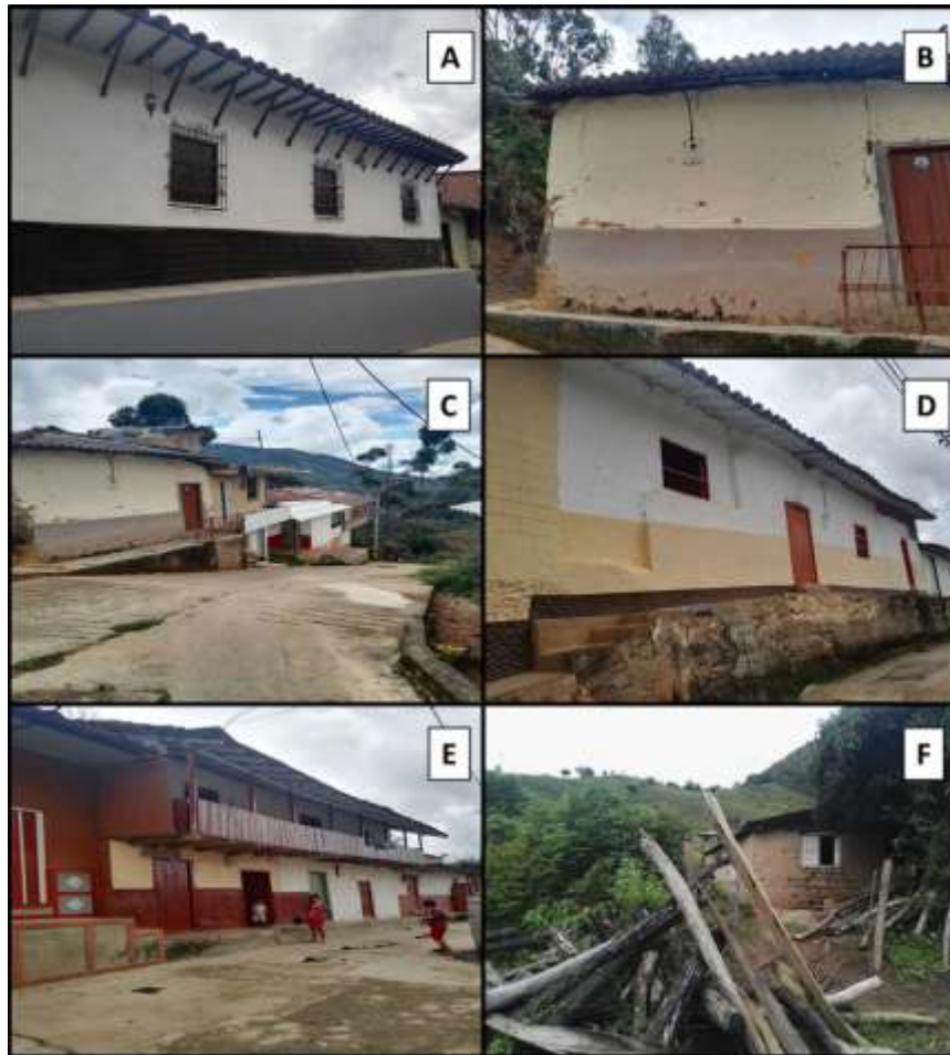
Figura 69. Aspecto de viviendas tipo V, Casas en tapia pisada. A, B,C,D y E: Sector El Filito, F: Sector La Gruta.
