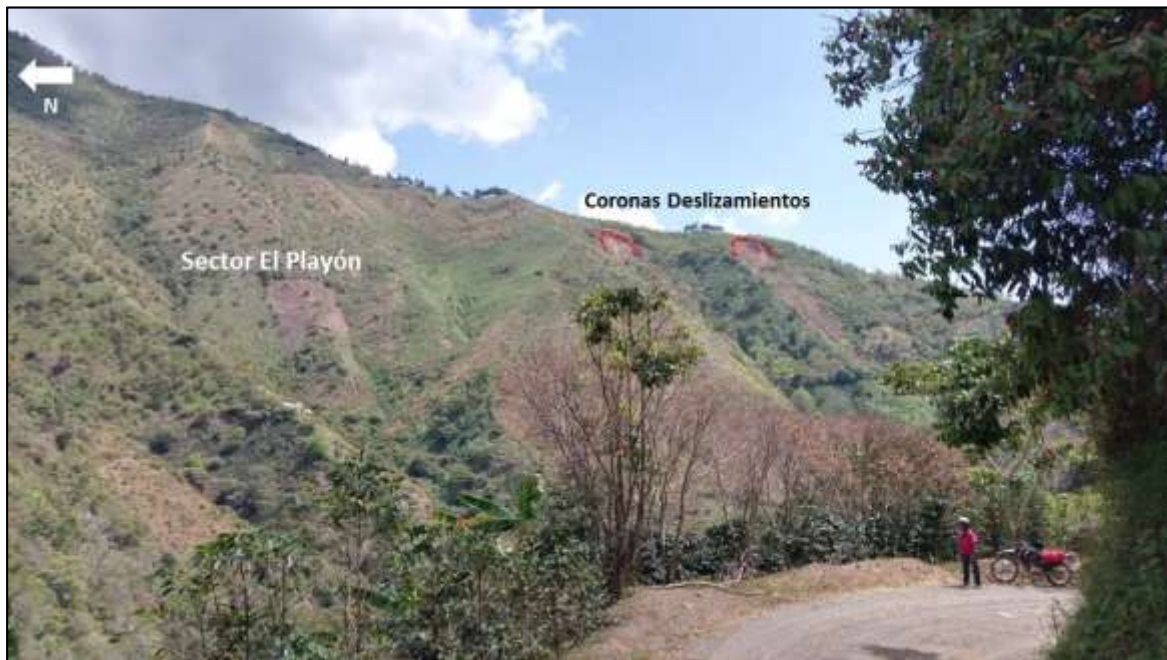
Figura 49. Carcavas retrogresivas con flujos en laderas de alta pendiente. Sector El Playón.
