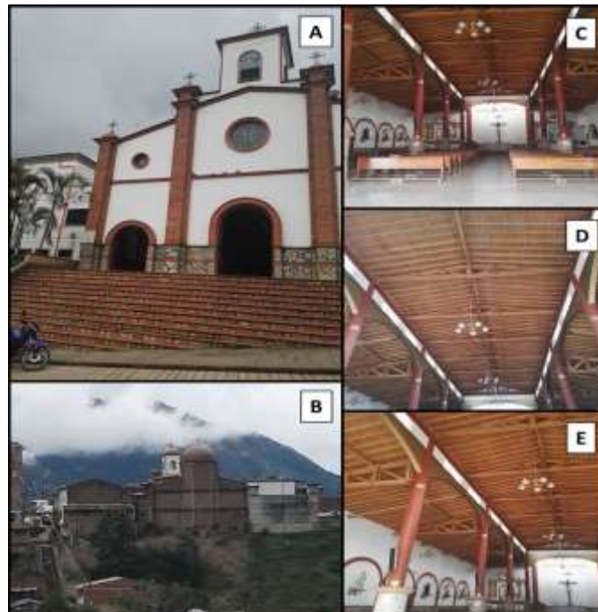
Figura 73. Aspecto edificación Tipo VI, Edificaciones Especiales. Parroquia Municipal Nuestra Señora de Las Mercedes, Sector Parque Principal. A: Fachada, B y C: Detalle Sistema Constructivo, D y E: Cubierta.
