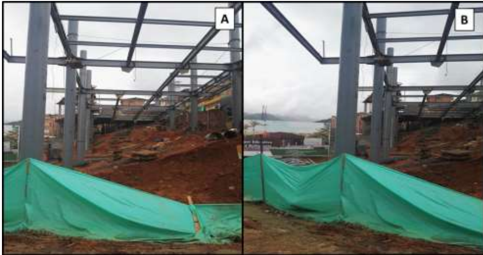
Figura 74. Aspecto de edificación Tipo VI, Edificaciones Especiales. Parque Educativo La No Violencia. A y B: Detalle Sistema Constructivo.
