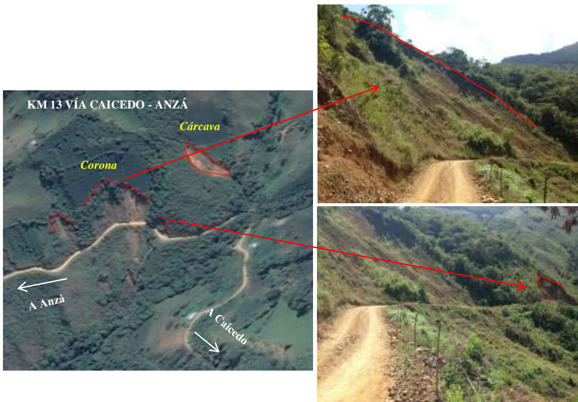
Figura 30. Kilómetro 13, sector de mayor afectación sobre la vía Caicedo – Anzá.
