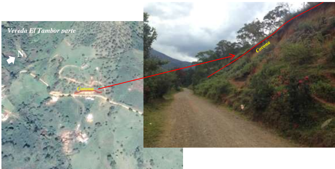
Figura 37. Deslizamiento antiguo e inactivo.
