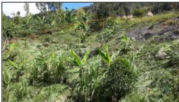
Figura 19. Cicatriz de deslizamiento margen izquierda quebrada Asesi.
