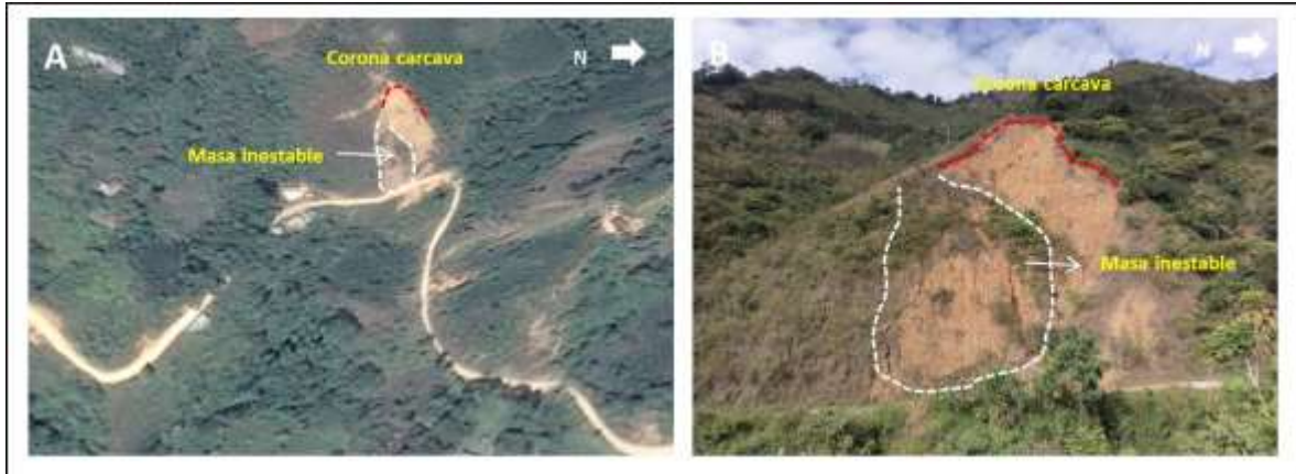
Figura 43. Carcavamiento Vereda Casanova. A. Imagen regional modificada Google Earth 2015. B. Carcava con masa inestable en vía Caicedo-Santa Fé.
