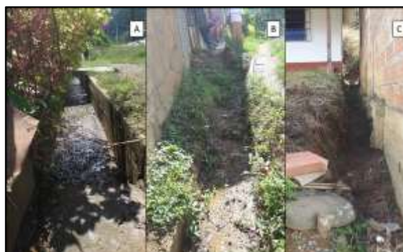
Figura 21. Canales para el control de agua de escorrentía actuales, sector La Gruta. A. Canal con intervención técnica pero con falta de mantenimiento. B y C. Canales artesanales sin ninguna intervención técnica.
