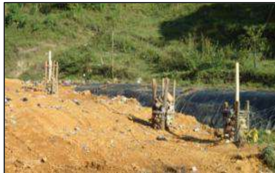
Figura 116. Relleno sanitario municipio de Caicedo
