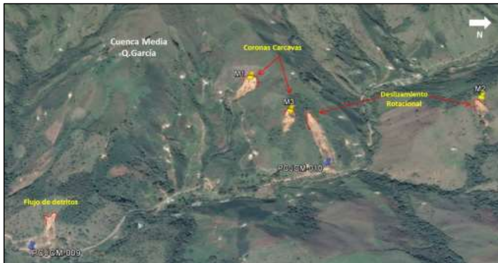
Figura 54. Sector de alta concentración de procesos erosivos. Vereda La García.
