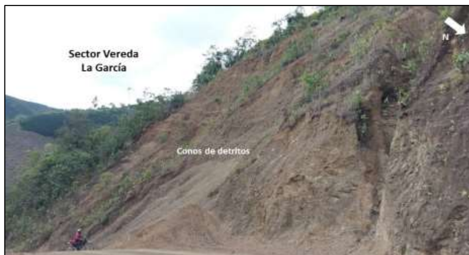
Figura 55. Movimiento complejo de Flujo de detritos con carcavamiento retrogresivo. Vía Vereda La García.
