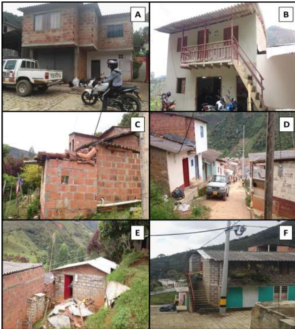
Figura 66. Aspecto de viviendas Tipo I. A, B y C: Sector La Bomba. D y E: Sector El Filito. F: Sector Cementerio – Girasoles.
