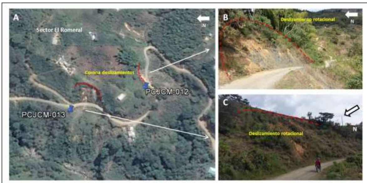
Figura 59. A. Movimientos rotacionales Sector El Romeral. Imagen modificada Google Earth 2015. B y C. Deslizamientos rotacionales estabilizados Sector El Romeral.
