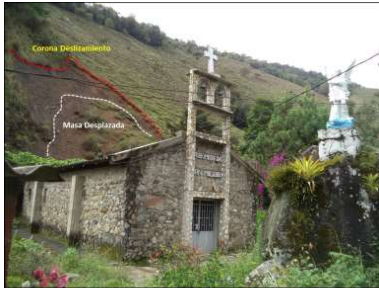
Figura 53. Deslizamiento rotacional. Vereda Anocozca.
