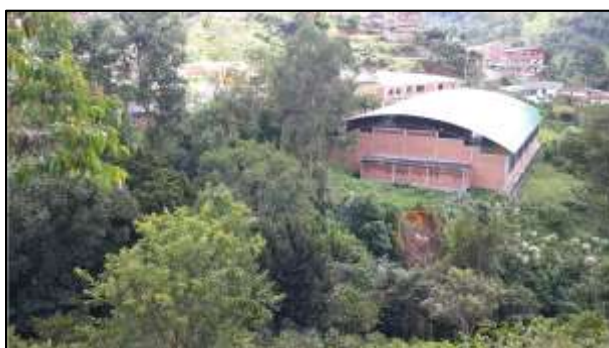
Figura 20. Cicatriz de deslizamiento sector occidental coliseo Eva Urán.
