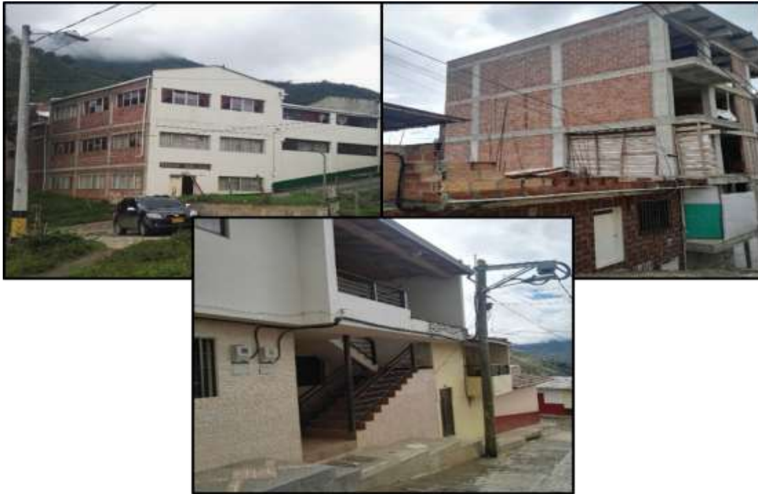
Figura 68. Aspecto De Vivienda Tipo 4 muros Diafragma – Sistema Aporticado (Sector Cementerio)
