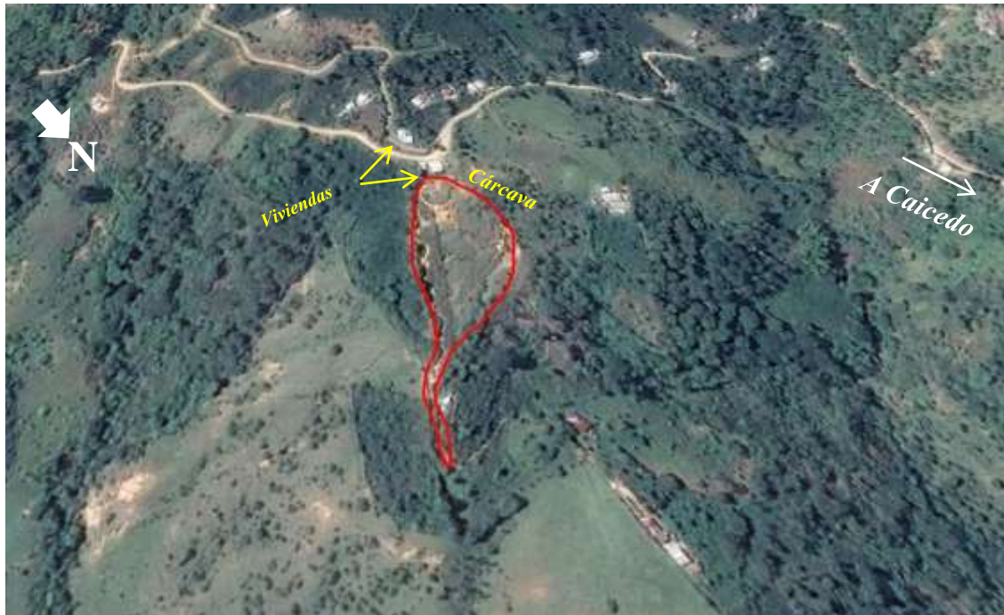
Figura 35. Carcavamiento formado por aguas superficiales en la parte baja de la vía Caicedo – Anza.
