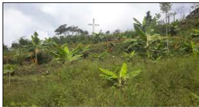
Figura 18. Cicatriz deslizamiento predio Pedro Carvajal.
