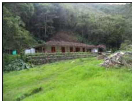
Figura 87. Finca Puerta del Medio vereda La Noque
