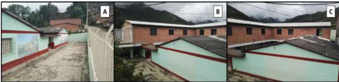
Figura 71. Aspecto edificación Tipo VI, Edificaciones Especiales. Institución Educativa San Juan Bosco, Barrio El Nogal. A, B, y C: Detalle Sistema Constructivo.
