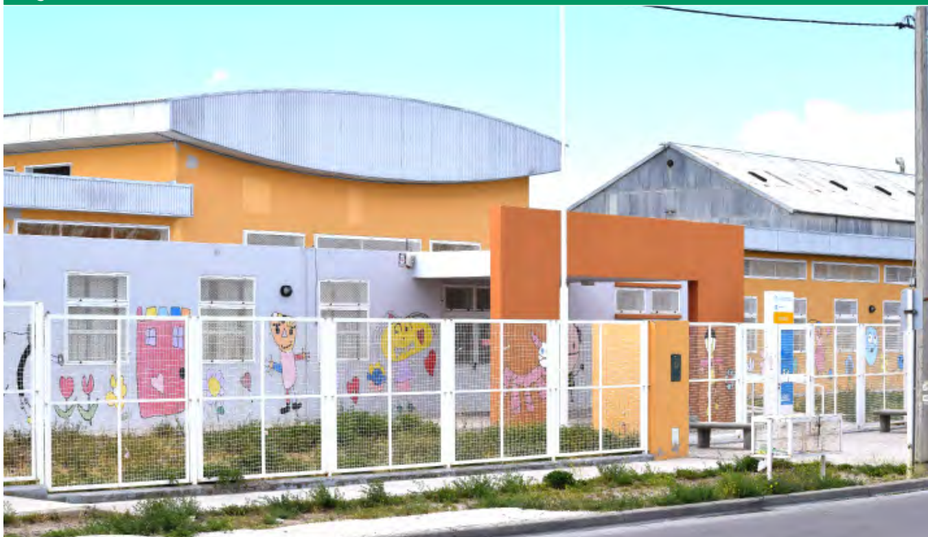
Imagen 46. Escuela Nivel Inicial 416 – Comodoro Rivadavia
