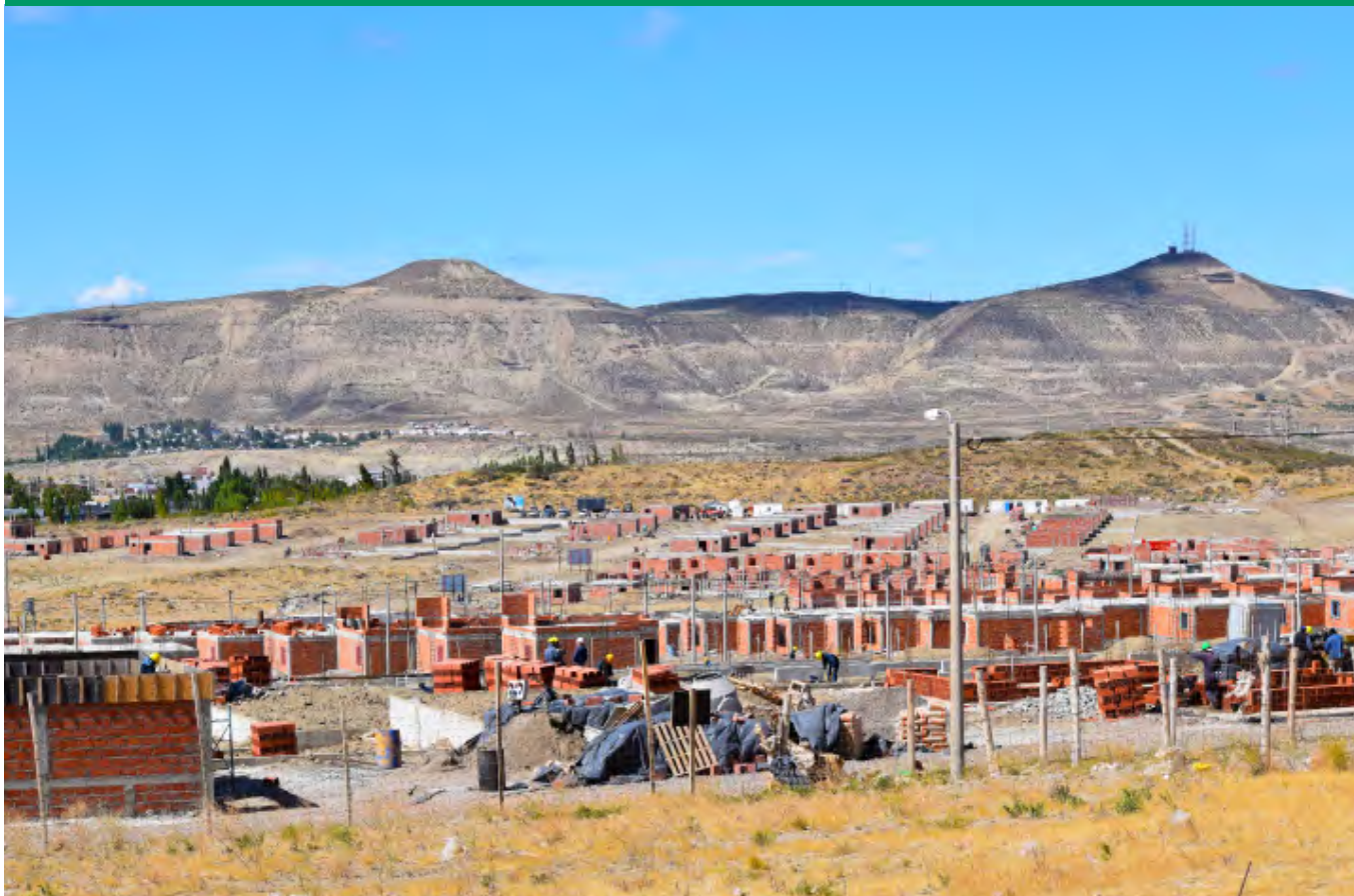
Imagen 44. Barrio Km 12 Acceso Norte - Comodoro Rivadavia
