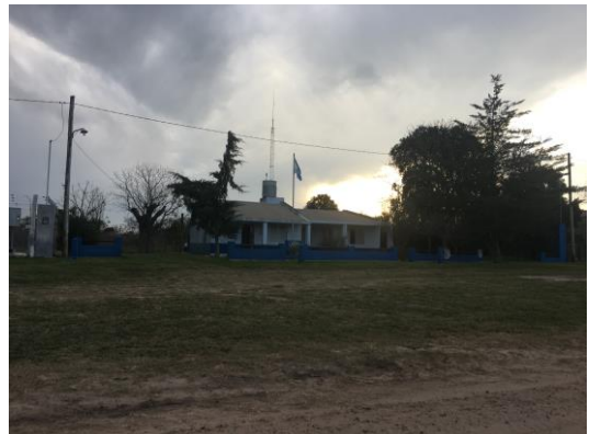
DESTACAMENTO FUENTE: Relevamiento propio 21/06/2018
