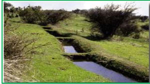
Sistema de drenaje lateral
