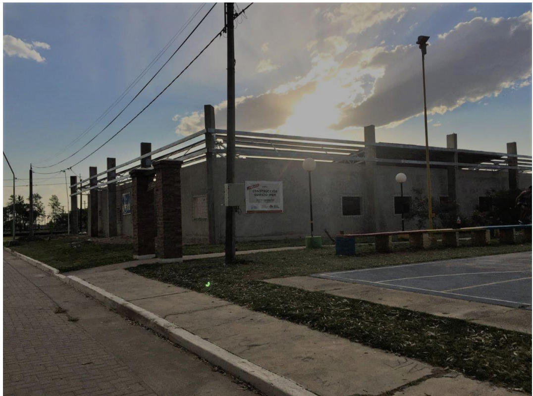
Nuevo edificio escolar para el nivel medio. FUENTE: Elaboración propia
