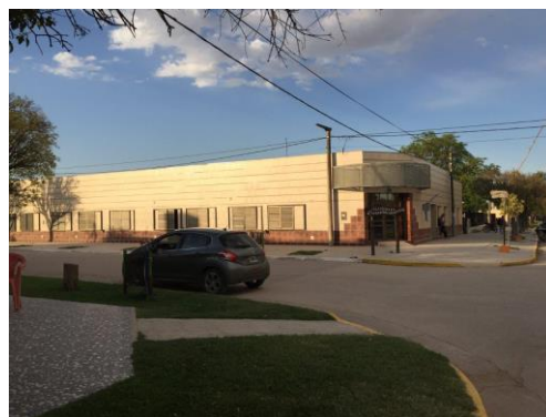
Edificio Escuela Antártida Argentina. FUENTE: Elaboración propia
