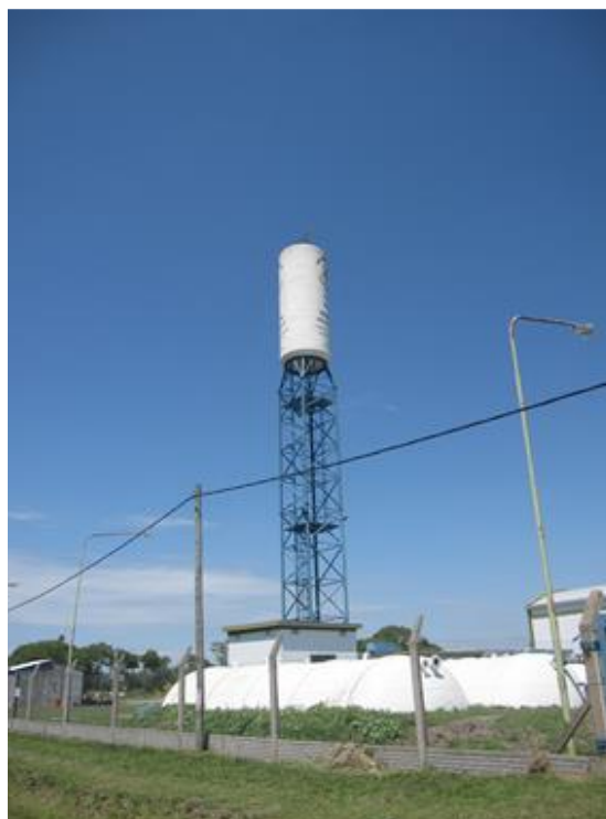
Tanque de la Cooperativa de Servicios Públicos Fuente: Elaboración Propia
