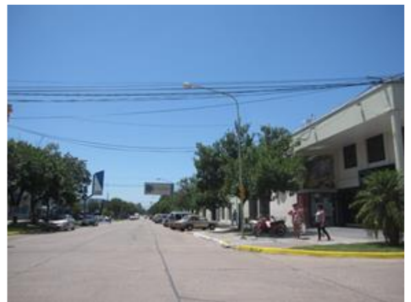
Alumbrado público con columnas de un brazo Área Central
