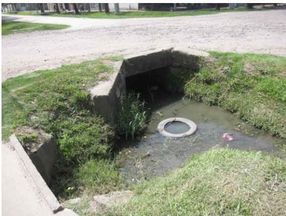
Saneamiento Insuficiente en zona periférica FUENTE: Elaboración propia
