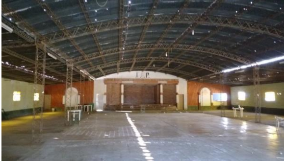
Salón comunal – Estado actual. Fuente: Elaboración propia
