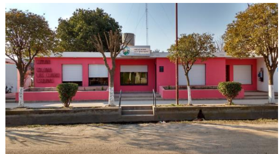
Edificio Comunal Área Central. Foto: Elaboración propia
