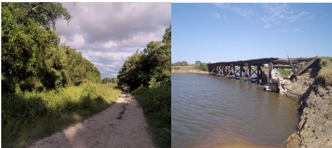
Camino y puente que conectan a Puerto Piracuacito. 19
