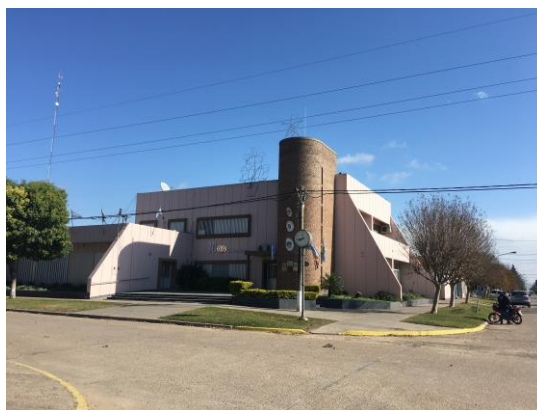
EDIIFICIO MUNICIPAL - FUENTE: RELEVAMIENTO PROPIO 21/06/2018
