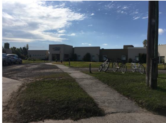
HOSPITAL PERU - GENERAL GALARZA | FUENTE: RELEVAMIENTO PROPIO 21/06/2018
