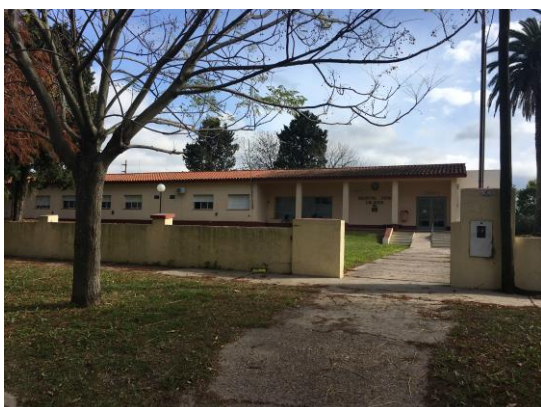
ESCUELA ECHEVERRIA GENERAL GALARZA | RELEVAMIENTO PROPIO 21/06/2018
