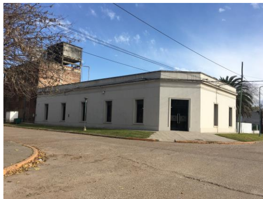
FACHADA ITALIANIZANTE - GENERAL GALARZA | RELEVAMIENTO PROPIO 21/06/2018
