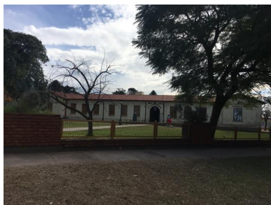
ESCUELA ECHEVERRIA GENERAL GALARZA | RELEVAMIENTO PROPIO 21/06/2018
