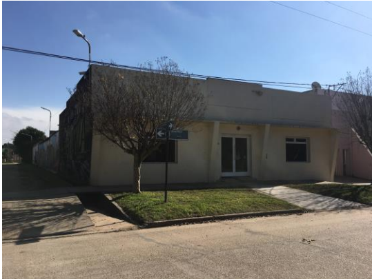
ANTIGUO MERCADO MUNICIPAL - GENERAL GALARZA | FUENTE: RELEVAMIENTO PROPIO 21/06/2018
