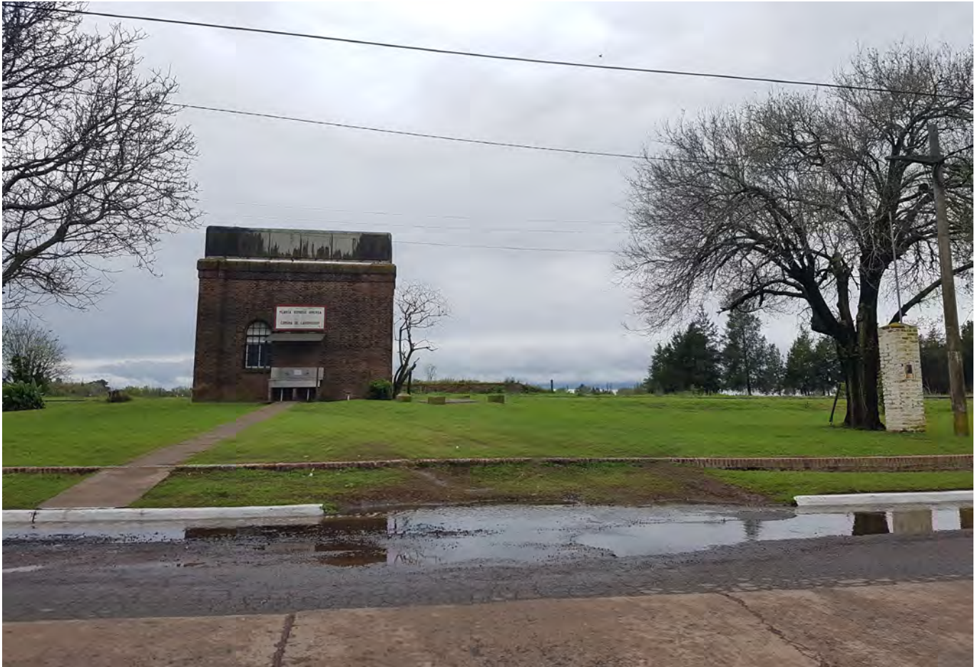
Planta de osmosis inversa
