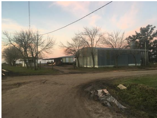
GALPONES FUENTE: RELEVAMIENTO PROPIO 11/07/2018
