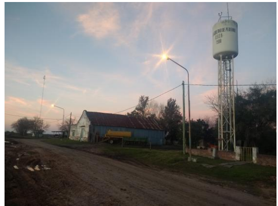
TANQUE DE AGUA FUENTE: RELEVAMIENTO PROPIO 11/07/2018
