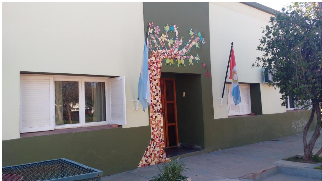
Edificio escolar. FUENTE: Elaboración propia
