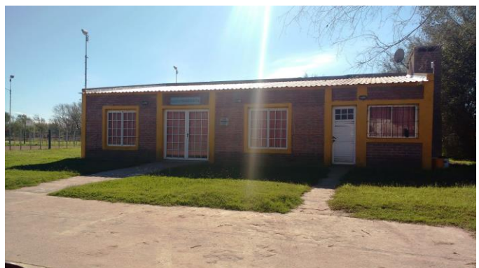
Edificio SUM Comunal FUENTE: Elaboración propia
