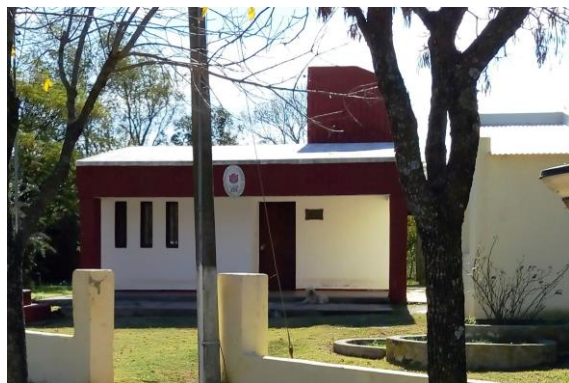
Edificio posta policial. FUENTE: Elaboración propia
