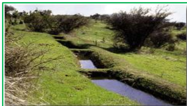
Sistema de drenaje lateral
