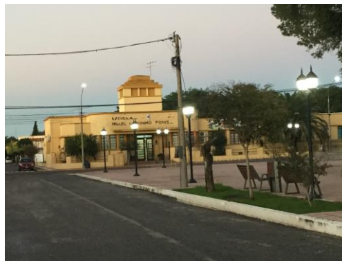
Edificio escolar FUENTE: Elaboración propia
