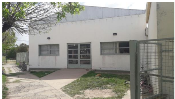
Escuela Primaria Área Central. Foto: Municipalidad Villa Fontana
