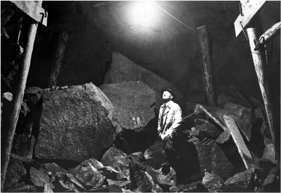
Felssturz beim Bau der Luftschutzbunker der Uhrenfabrik Gebrüder Junghans AG am 6. Mai 1941 (Stollen I). Foto: Uhrenfabrik Gebrüder Junghans (Stadtarchiv Schramberg)
