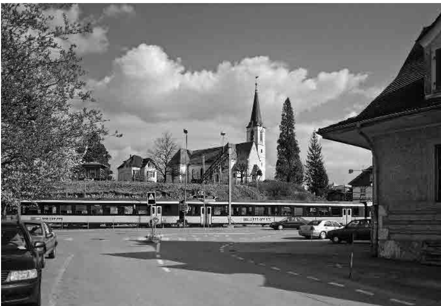
43 Bahnhofplatz und ref. Kirche, 1903
