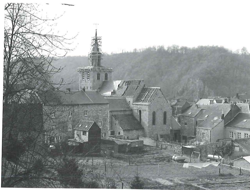
Les volumes caractéristiques d'une collégiale romane, notamment par son transept de type bas, juste en avant du chœur. Etat en cours de restauration (1979).
