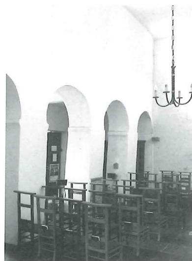
Deux aspects de la nef centrale du XI e s. : les fenêtres hautes (châssis reconstitués) et les étroites arcades sur piliers massifs du mur gouttereau sud.
