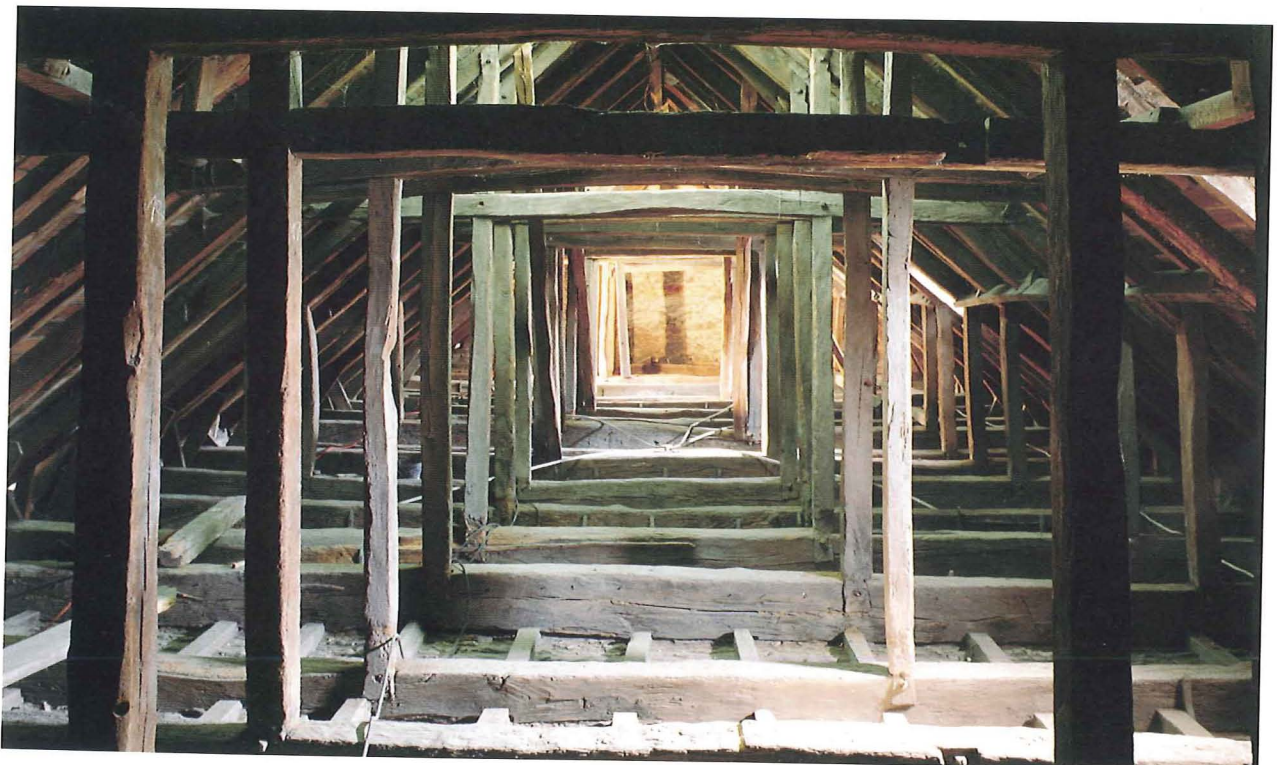
La succession rapide des fermes de charpente du vaisseau central, de la fin du XII e s.
