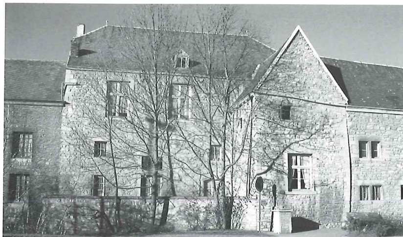
La portion de l'ancien hôpital occupée aujourd'hui par le presbytère. A droite, la petite aile perpendiculaire qui a conservé sa charpente primitive (en haut).
