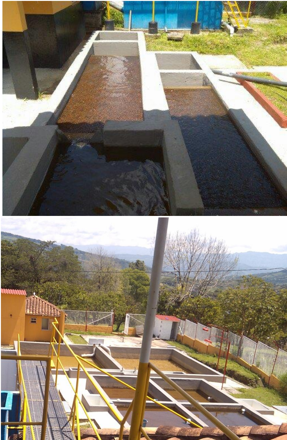
Figura 8. sistema de tratamiento de agua para consumo humano municipio de Togüí- sección FiME
