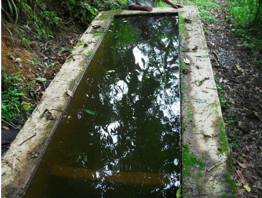
Figura 5. Desarenador municipio de Togüí.
