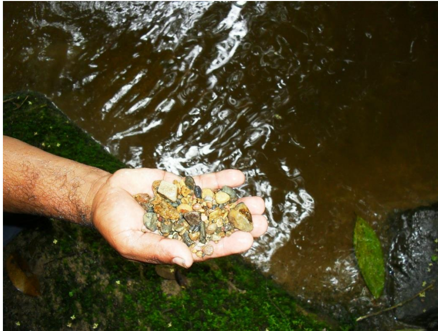
Figura 10. Material de arrastre presente en la bocatoma del municipio de Togüí.
