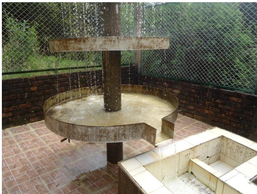
Imagen 7. Bandejas de Aireación.
