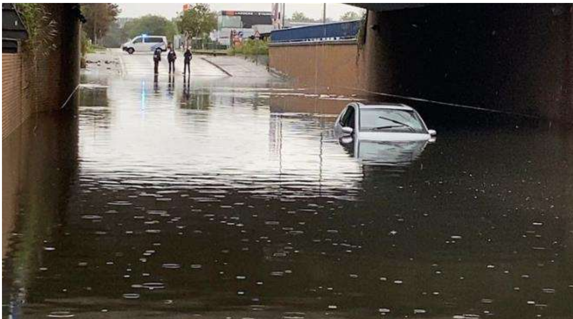
Figuur 24: Pluviale wateroverlast in de tunnel van de Kolvestraat op 30 augustus 2020.
