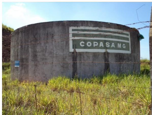
FIGURA 31 – RESERVATÓRIO R2 (FONTE: VALLENGE, 2014)
