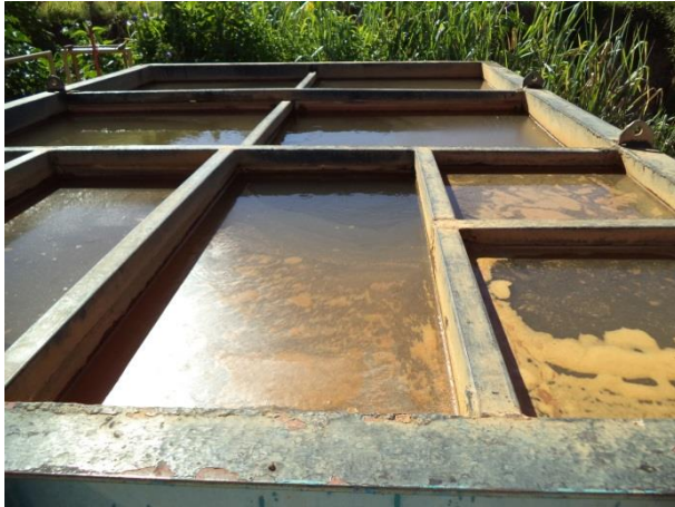
FIGURA 19 – ETA CONVENCIONAL (VISTA 1) (FONTE: VALLENGE, 2014)
