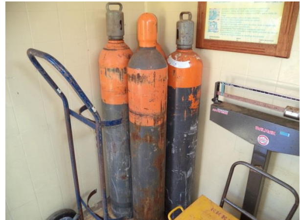
FIGURA 24 – ETA CONVENCIONAL (VISTA 6) (FONTE: VALLENGE 2014)
