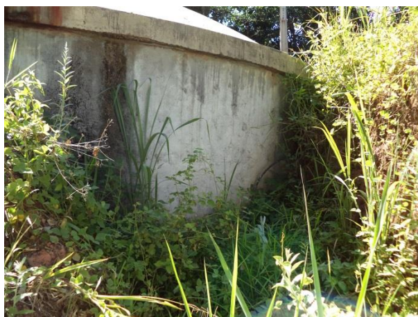
FIGURA 28 – RESERVATÓRIO R1 (FONTE: VALLENGE, 2014)
