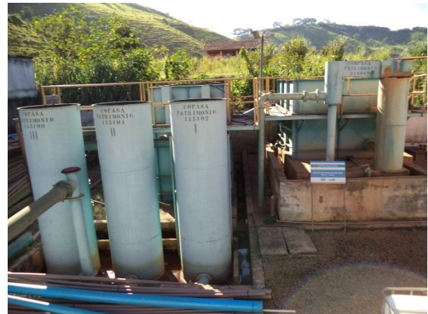
FIGURA 26 – ETA COMPACTA (VISTA 2) FONTE: VALLENGE, 2014)
