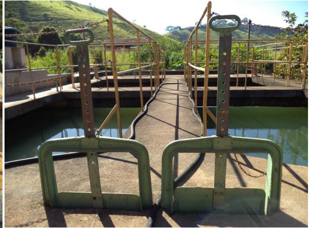
FIGURA 20 – ETA CONVENCIONAL (VISTA 2) (FONTE: VALLENGE, 2014)
