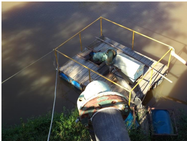
FIGURA 17 – CAPTAÇÃO (VISTA 1) (FONTE: VALLENGE, 2014)
