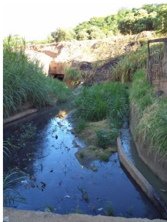
FIGURA 58—RUA JOÃO LOURENÇO TORRES (FONTE: VALLENGE, 2014)
