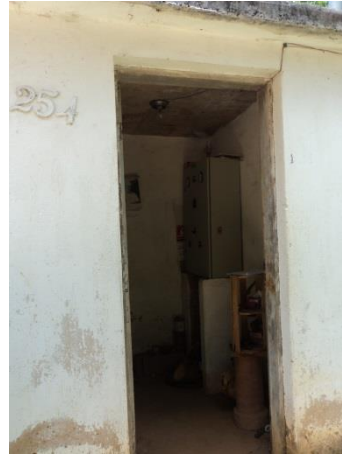
FIGURA 37 – POÇO TUBULAR JURUMIRIM (VISTA 2) (FONTE: VALLENGE, 2014)
