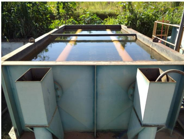
FIGURA 21 – ETA CONVENCIONAL (VISTA 3) (FONTE: VALLENGE, 2014)
