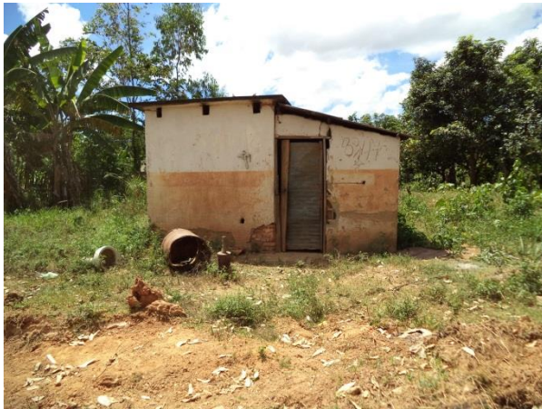
FIGURA 61—RUA JOÃO LOURENÇO TORRES (FONTE: VALLENGE, 2014)
