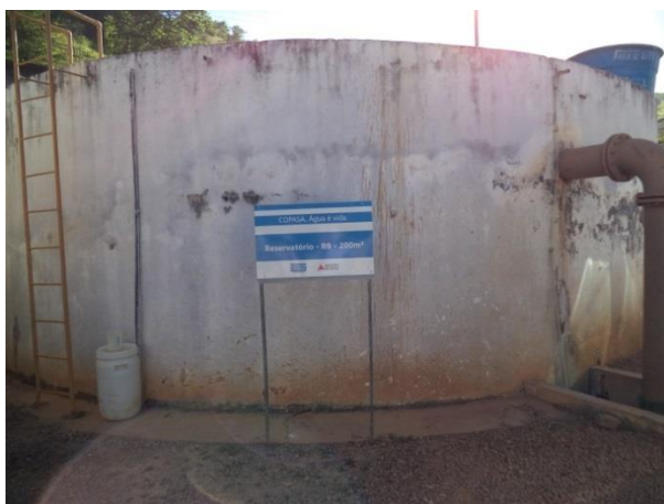
FIGURA 27 – RESERVATÓRIO R0 (FONTE: VALLENGE, 2014)
