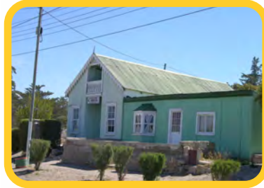
Antigua casa de chapa
