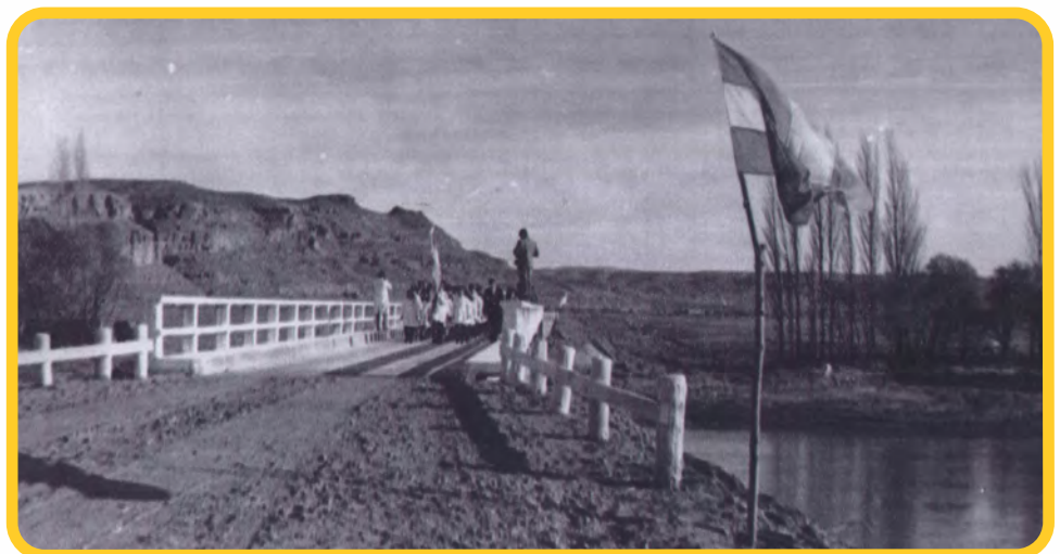
Inauguración del puente que une la localidad de Paso del Sapo con la ruta a Gastre Marzo de 1963
