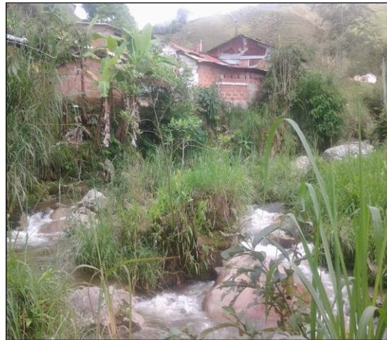
FIGURA 31. ASPECTO DE LA QUEBRADA LLANADAS EN EL BARRIO EL POBLADO
