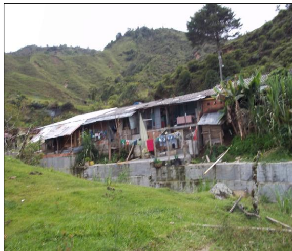
FIGURA 32. OBRAS DE CONTENCIÓN EN LA QUEBRADA LLANADAS, BARRIO SAN VICENTE
