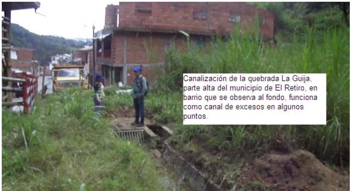
Figura 5. Entrada a cobertura de la quebrada La Guija en el municipio de El Retiro.
