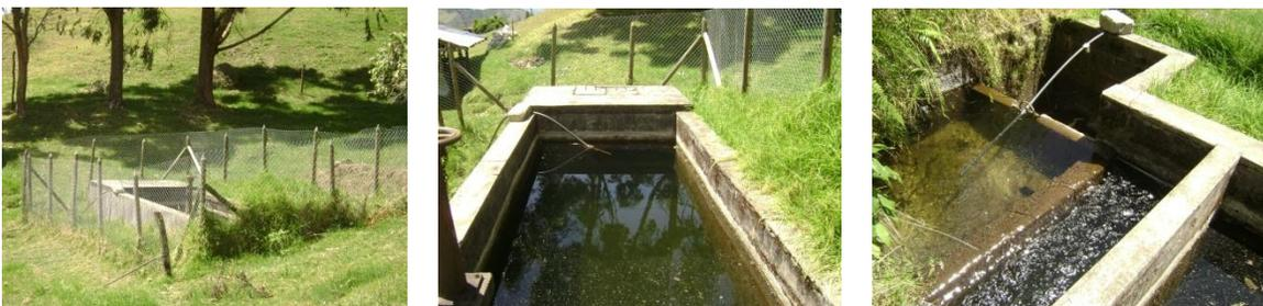
Foto 30. Desarenador quebrada La Angostura y tanque desarenador junto a la fuente, municipio Abejorral.
