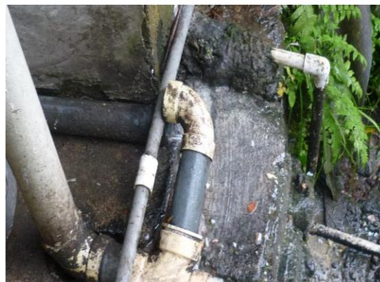
Foto 46. Inadecuado manejo de aguas residuales de las viviendas asentadas en la cuenca.
