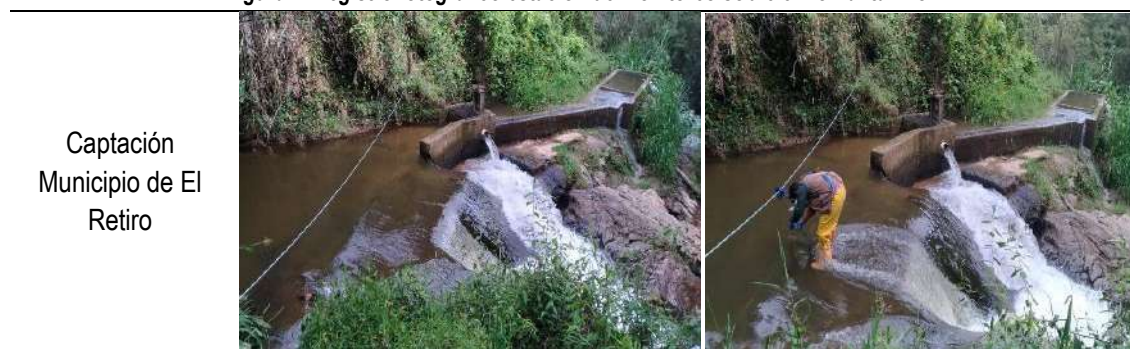
Figura 4. Registro fotográfico estación de monitoreo sobre el río Pantanillo
