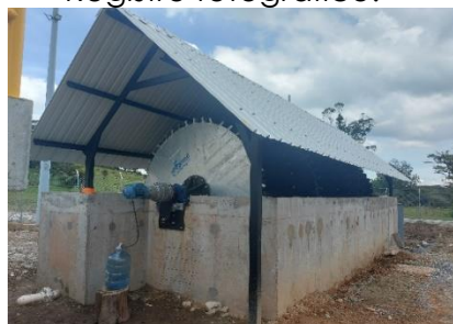
Instalación bódiscos PTARD Pontezuela
