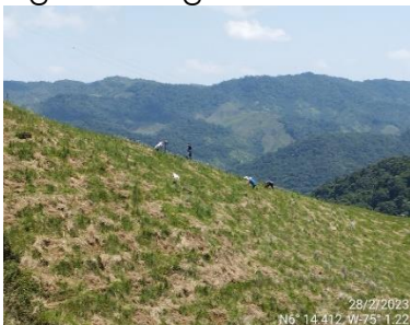
Proceso de la restauración ejecutada en San Rafael
