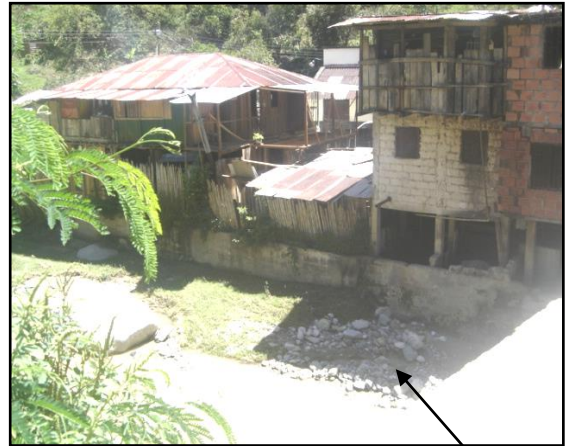
Foto 2. Zona Urbana del Municipio de Río Blanco.
