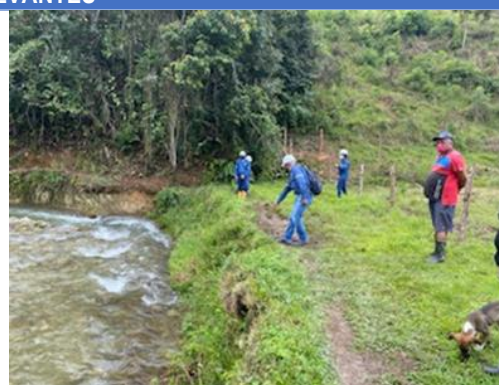
Foto 78. Sitio De Ejecución De Ocupación De Cauce Y Obra De Protección, DAR Pacifico Oeste.
