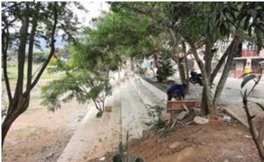
Foto 219. Construcción de graderías, solicitadas por la comunidad, para el disfrute del espacio público.
