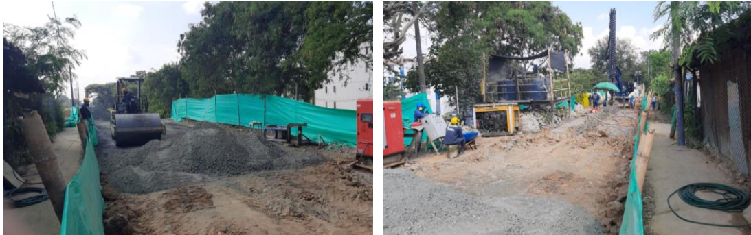
Foto 213. Avance de obra sector denominado lote 6ª.
