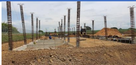
Foto 62. PTAR Yumbo - Edificios
