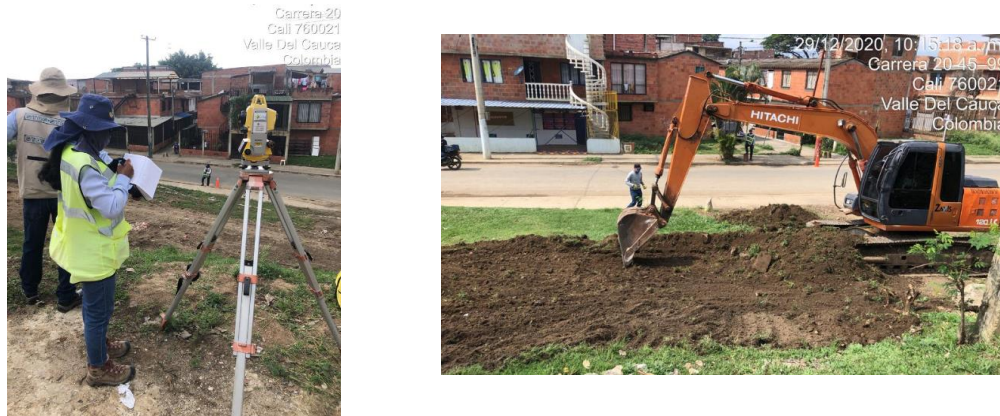
Foto 214. Avance de obra en el Sector Samanes. Replanteo y excavación.
