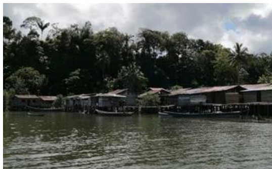
Foto 191. Monitoreo a escenarios de riesgo por erosión fluvial en la cuenca del río Mayorquín, Buenaventura.
