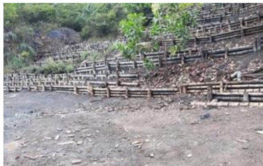
Foto 20. Después. Instalación de trinchos en guadua para la conformación y estabilización del suelo, Cerro de la Bandera, Santiago de Cali.
