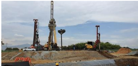
Foto 60. PTAR Yumbo - Columnas de grava (cimentación).
