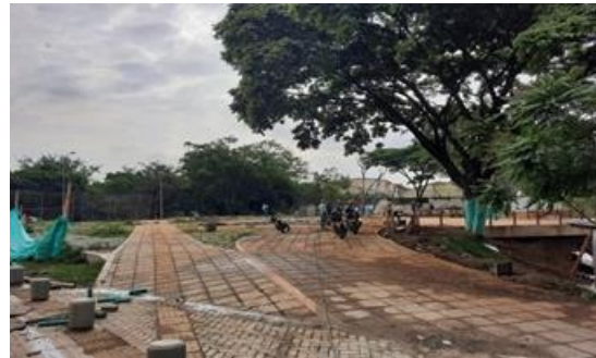
Foto 220. Construcción de mobiliario y senderos en adoquín.
