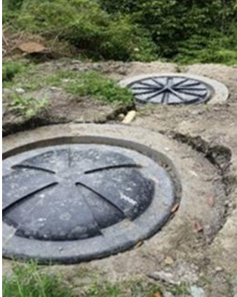
Foto 75. Construcción del sistema de tratamiento de aguas residuales para la comunidad indígena de Guasiruma.
