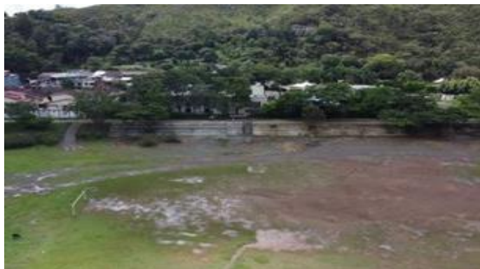
Foto 136. Nuevas Graderías en el Embalse Cañaveralejo. Archivo CVC 2021
