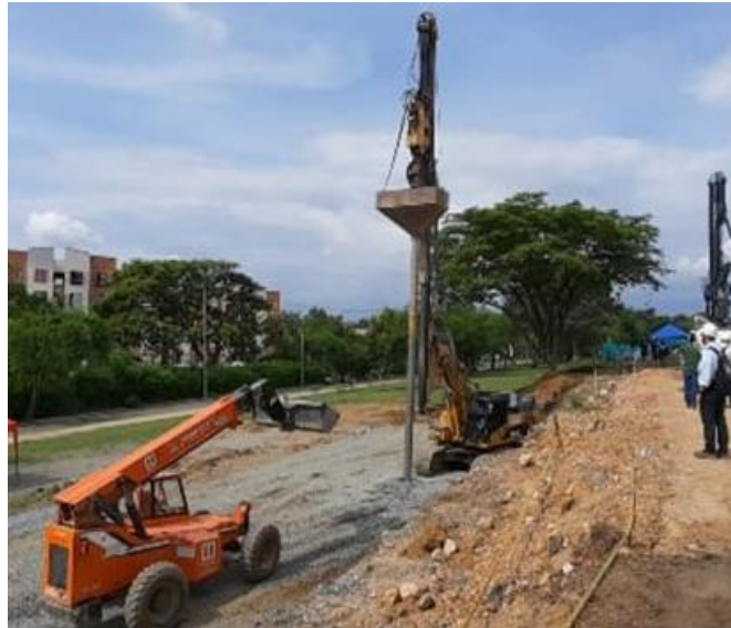
Foto 135. Reforzamiento del Dique - Plan Jarillón
