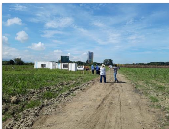
Foto 28. Avance construcción PTAR Guadalajara de Buga
