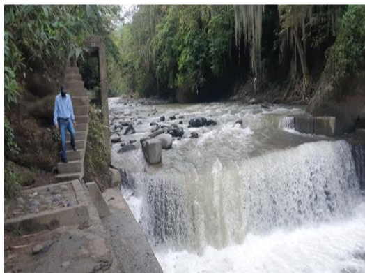
Foto 37. Concesión Aguas Superficial: Obra de captación de aguas, Acequia Chambimbal, Derivación 4 del río Guadalajara, municipio de Buga. Archivo CVC. 2021.
