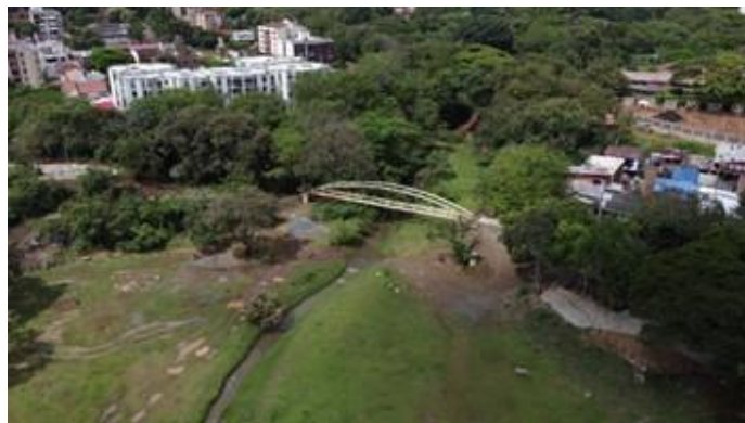
Foto 137. Construcción del puente peatonal sobre el Río Cañaveralejo, La Quebrada contingente, atravesando el embalse. Archivo CVC 2021
