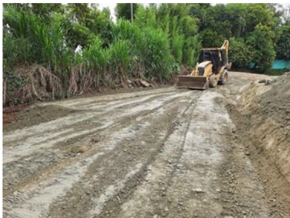
Foto 99 Puesta de material de cobertura de las zonas a clausurar en proceso de cierre y restauración técnica
