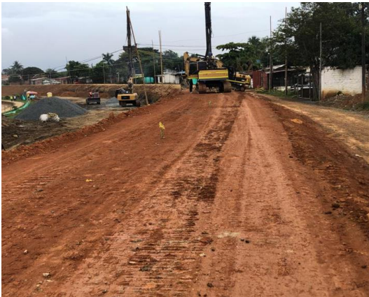
Foto 132. Reforzamiento del Jarillón. Archivo CVC 2021
