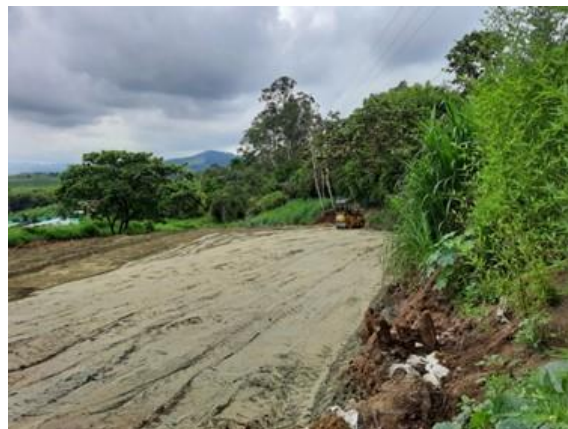
Foto 100 Compactación de material de cobertura de las zonas a clausurar en proceso de cierre y restauración técnica.
