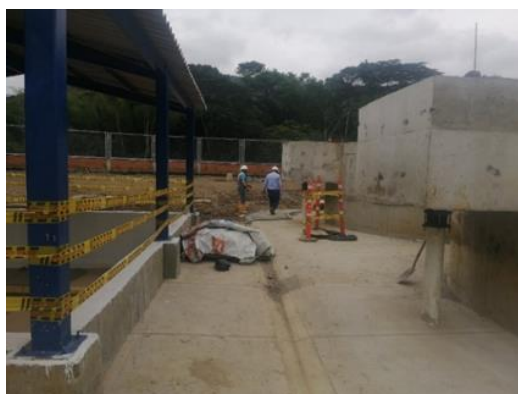
Foto 41. Seguimiento PSMV: PSMV Corregimiento de Salónica, municipio de Riofrio obras de construcción PTAR. Archivo CVC. 2021.
