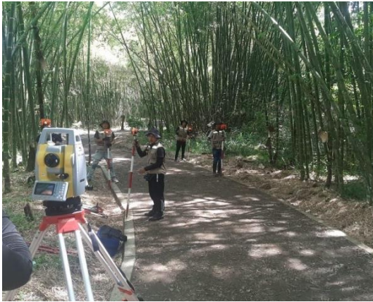
Foto 97. Levantamiento Topográfico Ecoparque Pance
