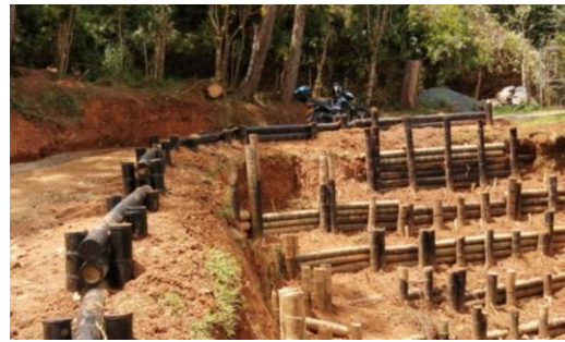
Foto 112. Obras de control de Erosión. Corregimiento La Leonera
