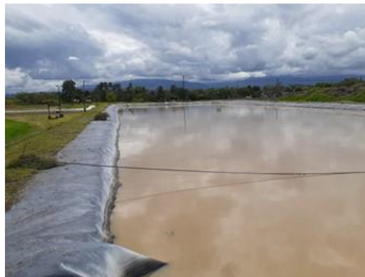
Foto 38. Renovación permiso vertimientos: Sistema de Tratamiento de Aguas Residuales no Domésticas de la empresa Industrias Alimenticias El Trébol – Laguna de Estabilización, municipio de Andalucía. Archivo CVC. 2021.
