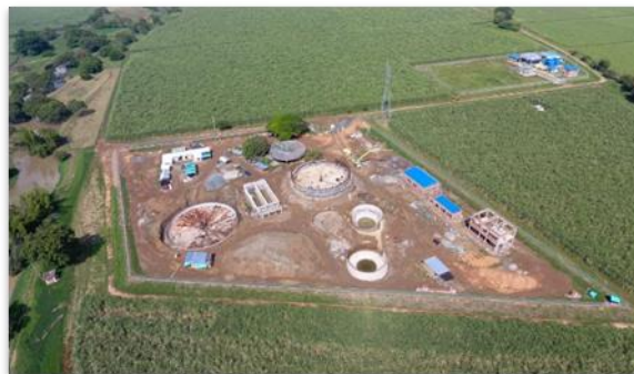
Foto 27. Avance construcción PTAR de Yumbo
