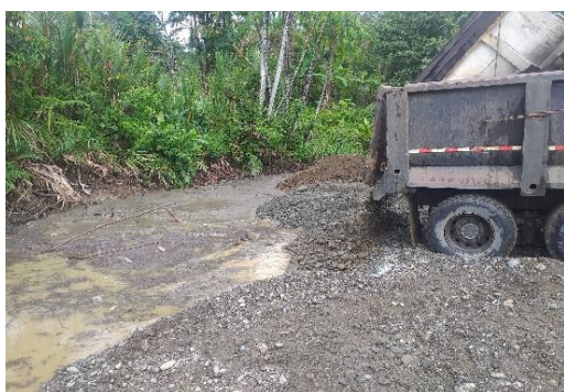
Foto 11. Relleno de Fosas Sector Don Ventura.
