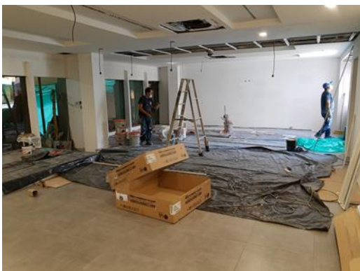
Foto 29. Estado Actual obra
