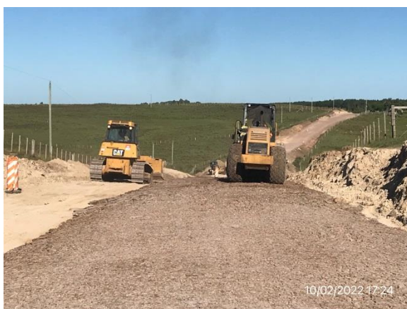
Ilustración 8 – P05, Frente de obras. Trabajos de desmote y recargo de base en ejecución.
