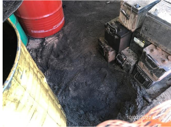
Ilustración 17 – P04, Obrador. Acopio de baterías en local techado, envallado y con pavimento impermeable.
