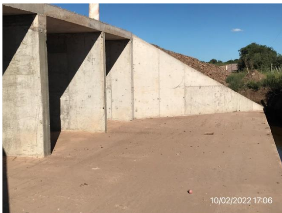
Ilustración 6 – P06, Alcantarilla construida. Cno. El Arbolito, progresiva 4K600.
