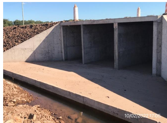
Ilustración 7 – P06, Alcantarilla construida. Cno. El Arbolito, progresiva 4K600
