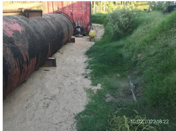
Ilustración 19 – P04, Obrador. Depósito de emulsiones en sector con pavimento impermeable y envallado perimetral.
