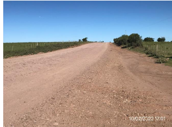
Ilustración 5 – Cno. El Arbolito. Trabajos de ensanche y perfilado de base ejecutados.
