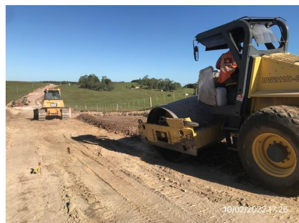
Ilustración 9 – P05, Frente de obras. Trabajos de desmote y recargo de base en ejecución. No hay campamento provisorio en las proximidades.
