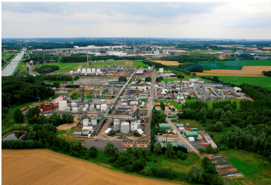
Figure 3 : Vue du nord du Zoning de Feluy, au premier plan les installations de Afton et de Ineos, à gauche le Canal Charleroi-Bruxelles, en arrière plan Total Petrochemicals, BASF, Chemviron Carbon, Geocycle.
