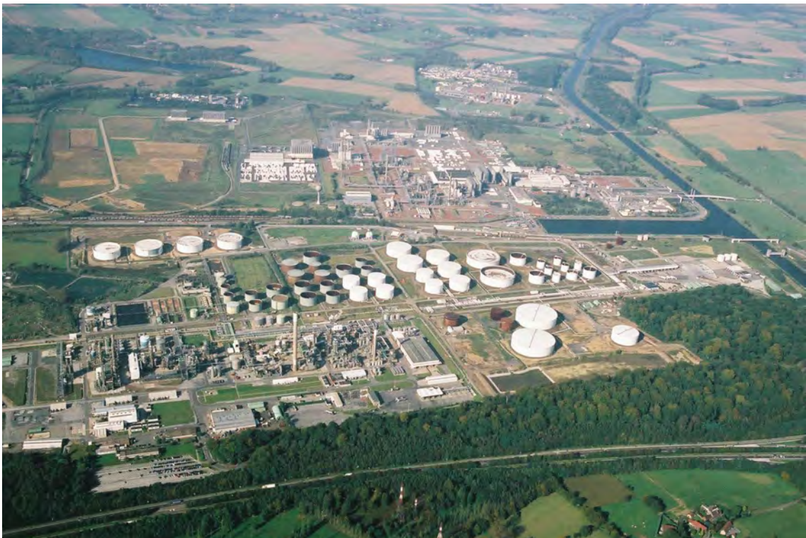
Figure 4 : Vue du sud du Zoning de Feluy, au premier plan les installations de BASF et de Total, à droite le Canal Charleroi-Bruxelles.
