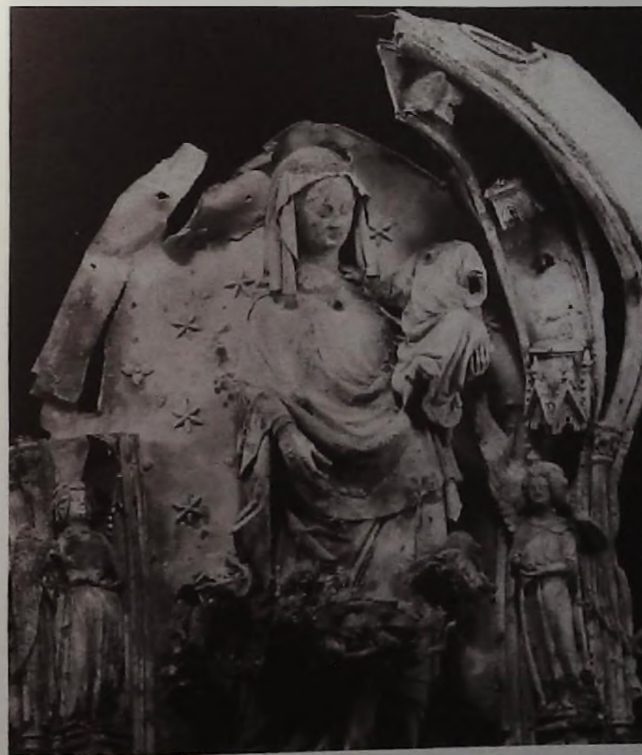
Fig. 14 — Images de la destruction de la chässe du 13 e siècle. 1941. Photo A.C.L., Bruxelles a, éléments d'un pignon, b, pignon de la Vierge.
