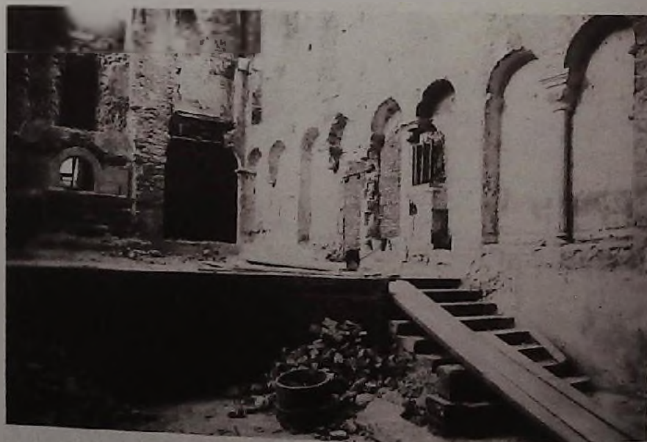
Cat. 36 Vue des travaux dans le chœur oriental de la collégiale vers 1901.
