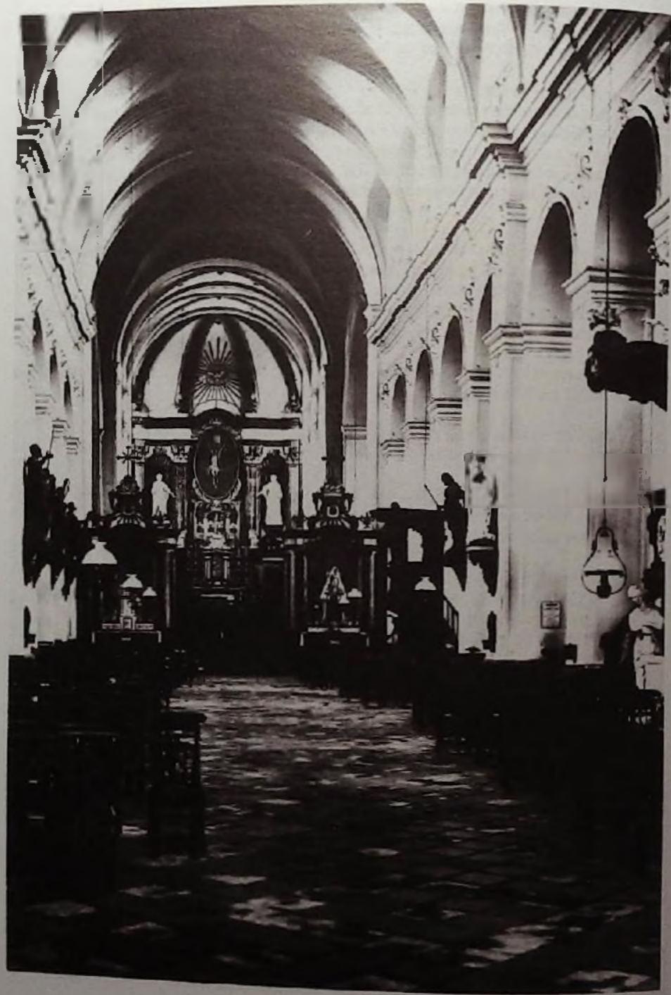
Cat. 32 Vue intérieure de la collégiale vers l'est en 1891. Photo A.C.L., Bruxelles.
