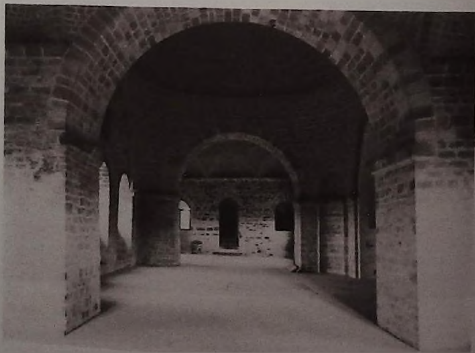
Fig. 10 — « Salle Impériale »: vue vers le nord, après restauration. Photo W. Hanss.
