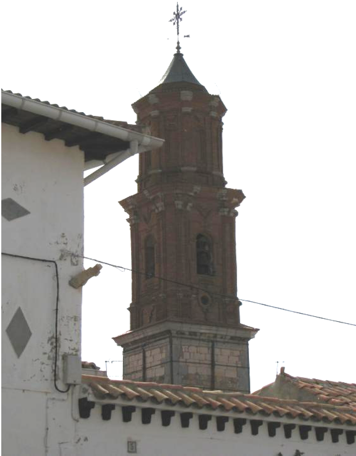
Empotrado en la esquina sureste de la casa. Muy deteriorado.
