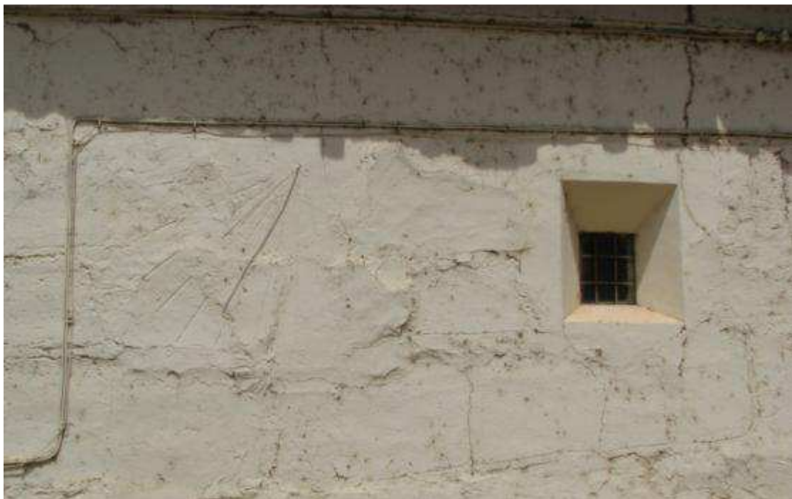
Grabado en el enlucido de yeso, entre las dos ventanas abocinadas.
