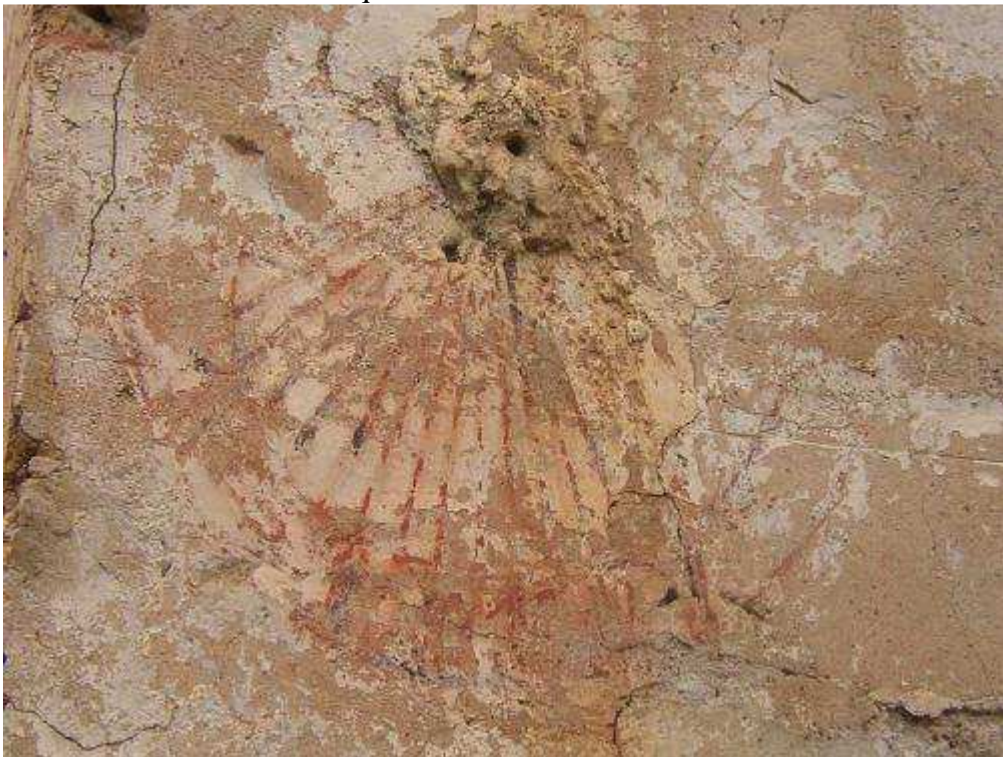
Números árabigos. Líneas de medias horas. Varilla de un apoyo desaparecida.
