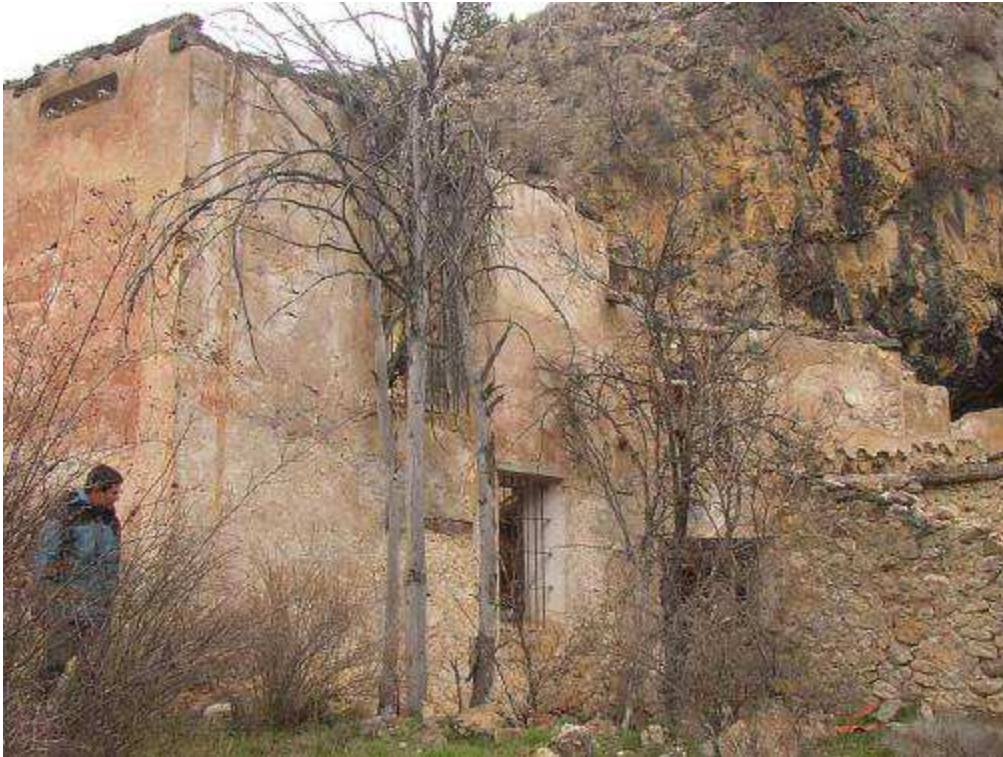
Situado en la esquina suroeste de un edificio en ruinas.
