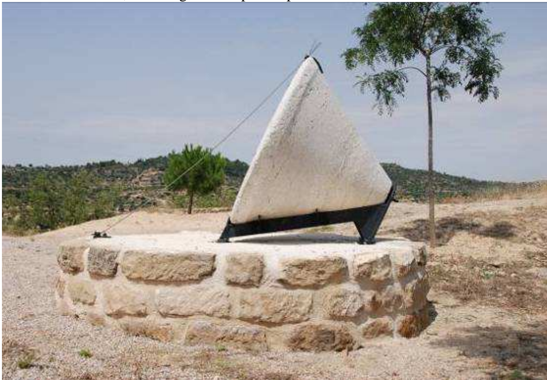
Lateral. Plinto cilíndrico de sillarejo, soporte metálico, piedra de moler y gnomon.
