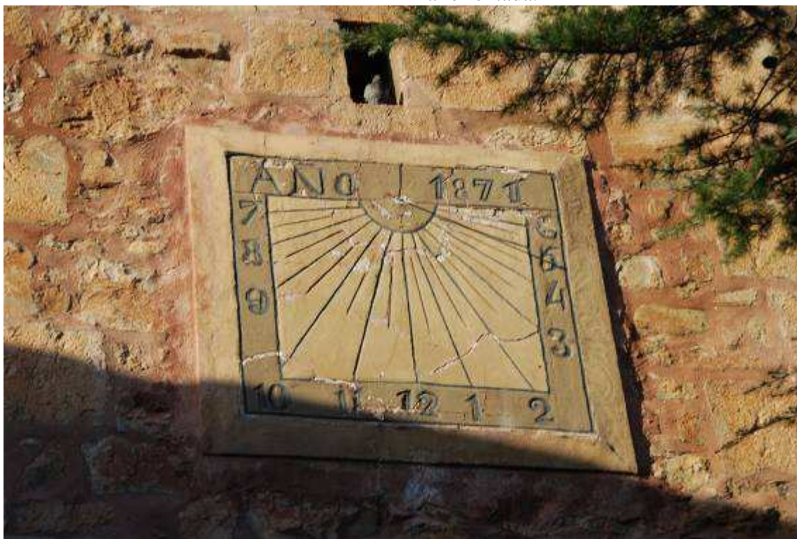
Varilla mal orientada. Fotografiado el 6/10/2010 a las 17:34.
