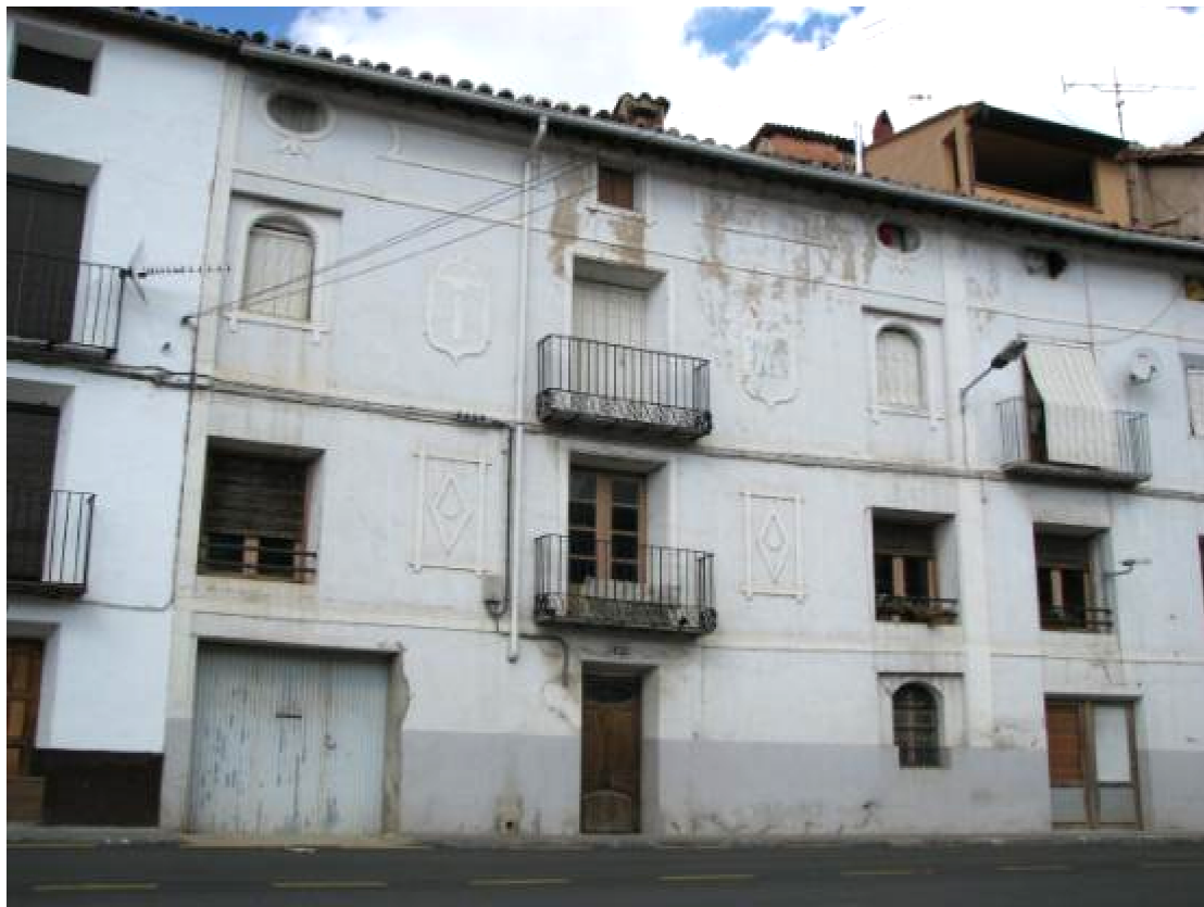
Reloj de sol a la derecha del balcón de la segunda planta.
