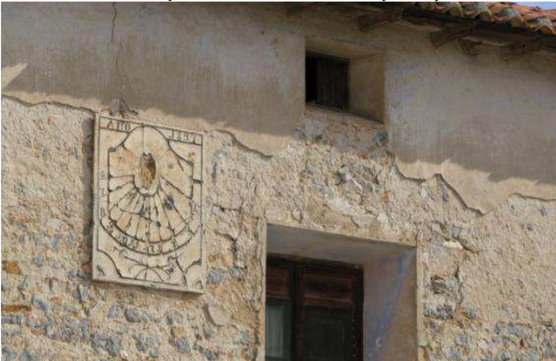
Esgrafiado en una superficie rectangular enlucida que sobresale del muro.
