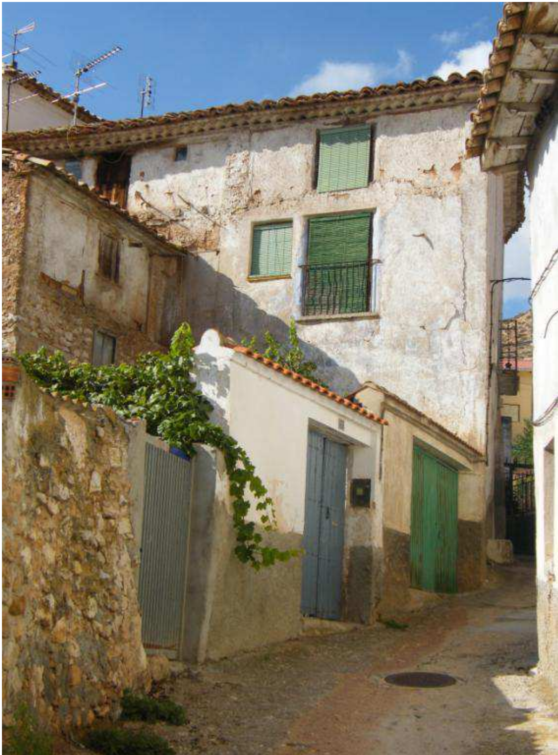
Situado a la derecha del balcón de la primera planta, en la fachada trasera..
