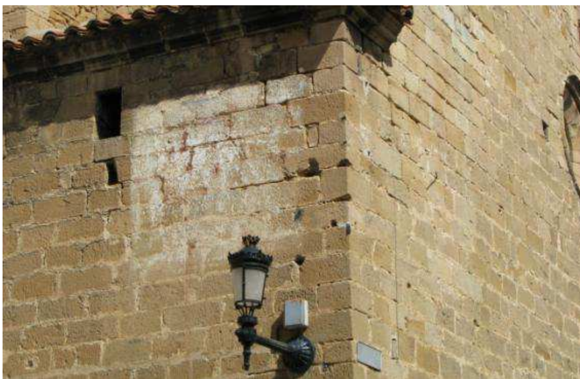
Reloj doble situado en la esquina sureste de la iglesia.
