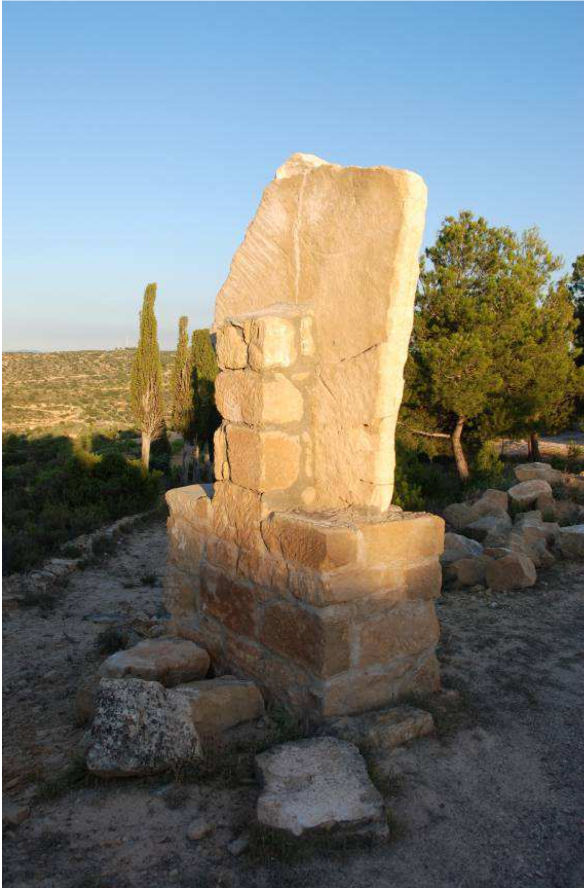
Vista posterior. Refuerzo para sujetar la laja de piedra: paredeta.
