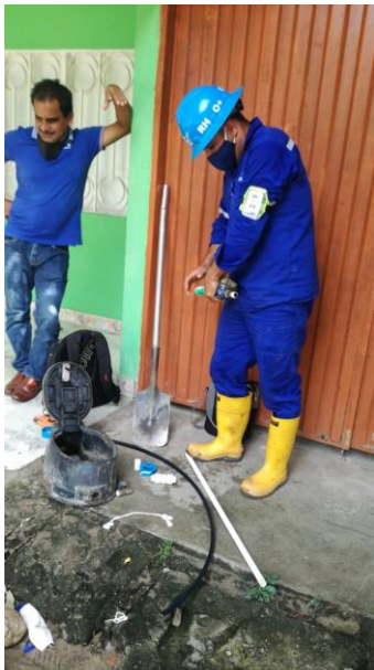
Instalaciones acometidas nuevas de acueducto
