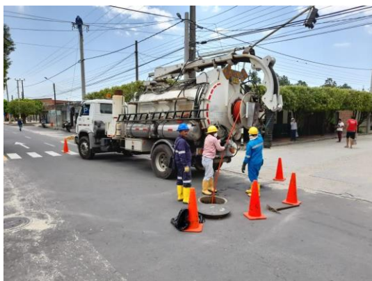
Limpeza y mantenimiento de redes de alcantarillado
