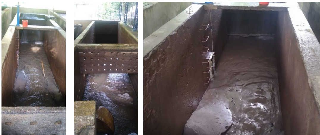
mantenimiento y lavado de desarenadores
