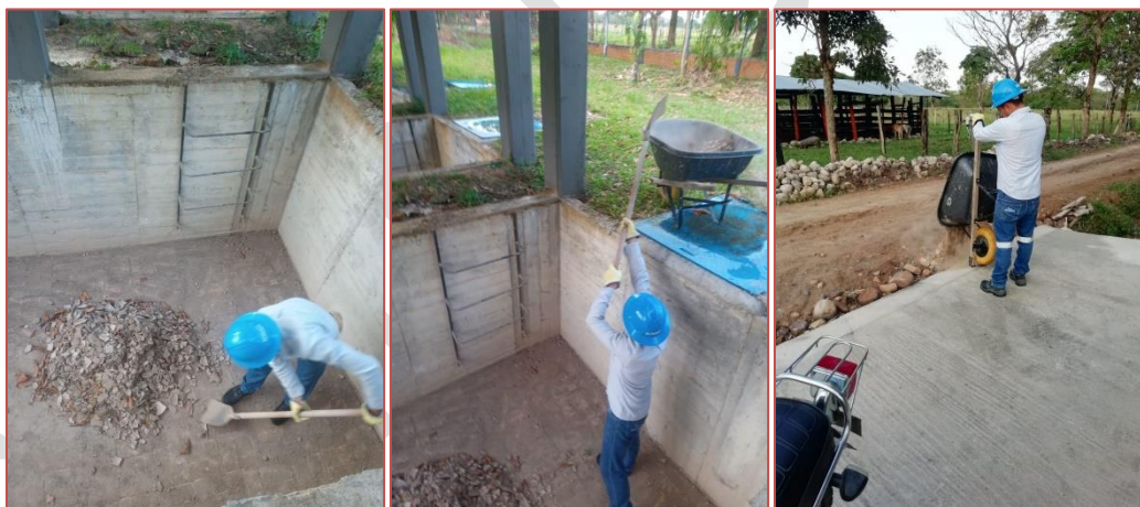
Aprovechamiento de lodos para relleno de huecos
