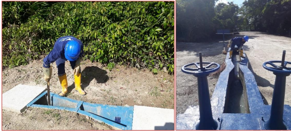
Aforo de caudal en canaleta parshall a la entrada y salida del STAR
