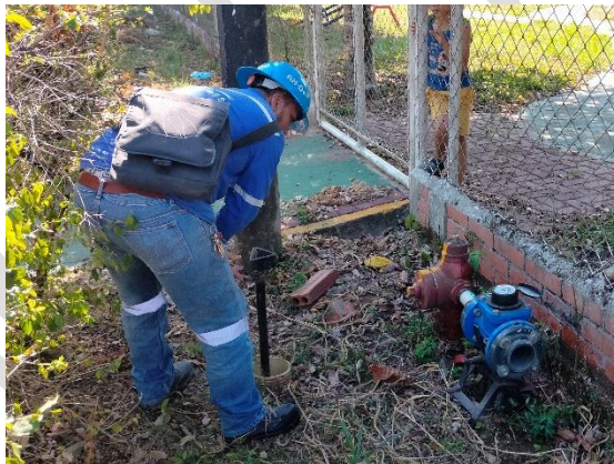
apertura de hidrantes y purgas
