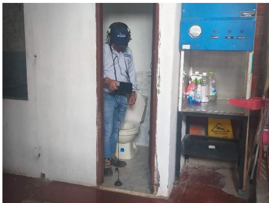
Detección De Fugas Intradomiciliarias
