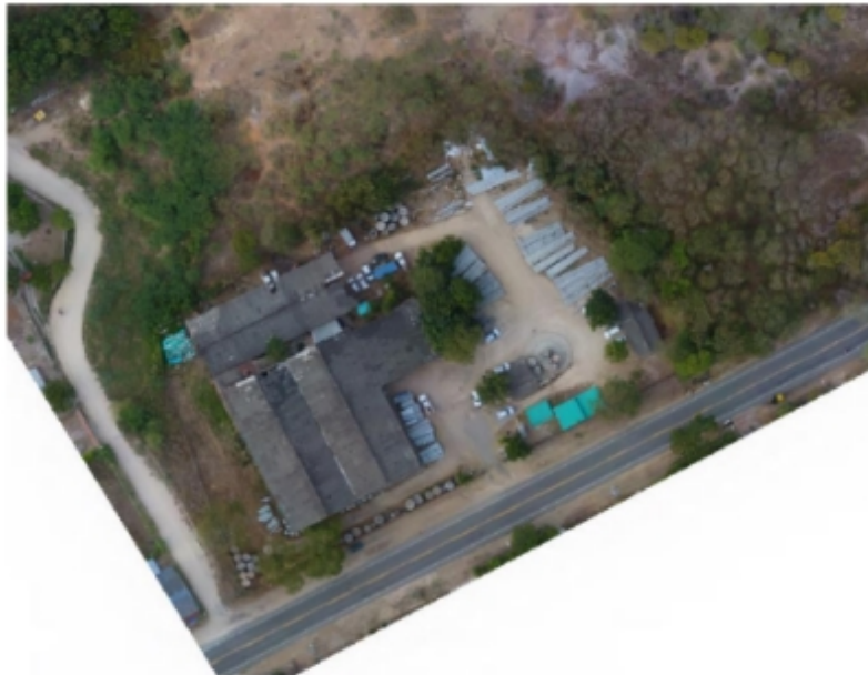
Fotografía 5-112 Predio destinado para la subestación
