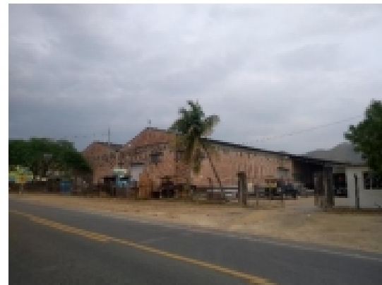
Fotografía 5-38 Predio destinado para la subestación
