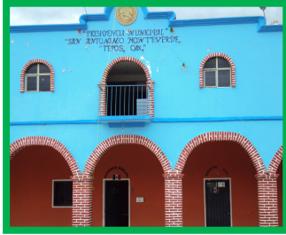
Infraestructura del palacio municipal
