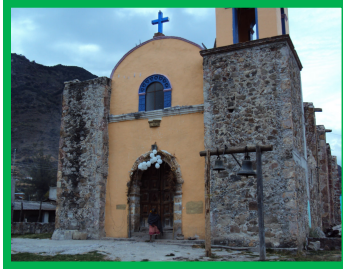
Infraestructura de la iglesia de San Antonino Monteverde
