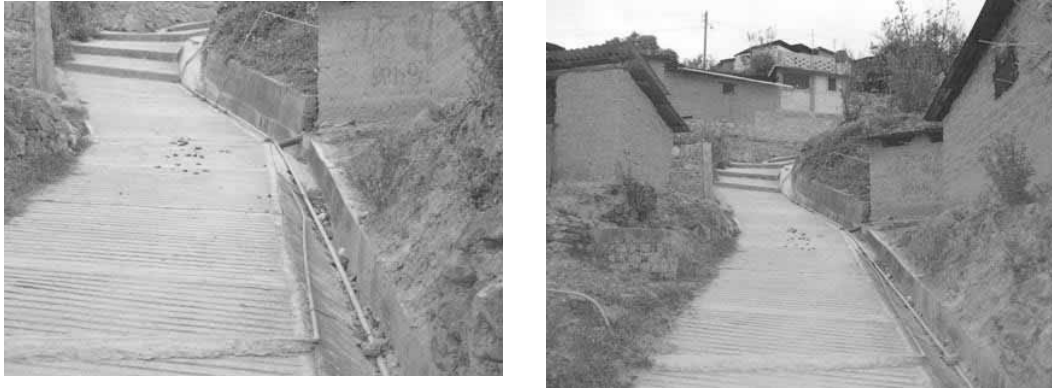
Imagen 3.- Pavimentación de las calles y sistema de agua potable
