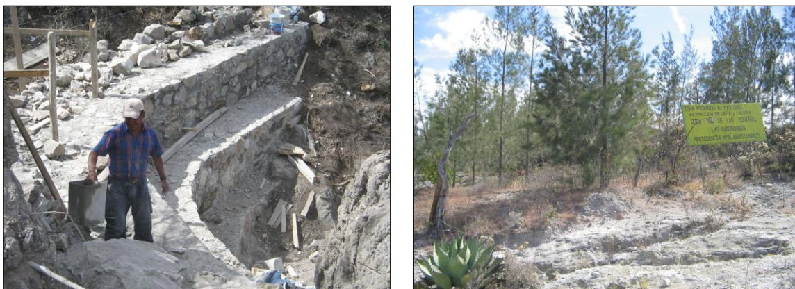
Figura 9. Construcción de presa para retener suelo y agua, así como el establecimiento de área de conservación, en zona de río agua dulce, Teotongo.
