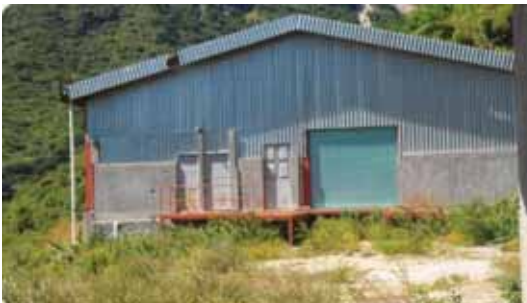
PLANTA PURIFICADORA DE AGUA PROPIEDAD DEL LA COMUNIDAD
