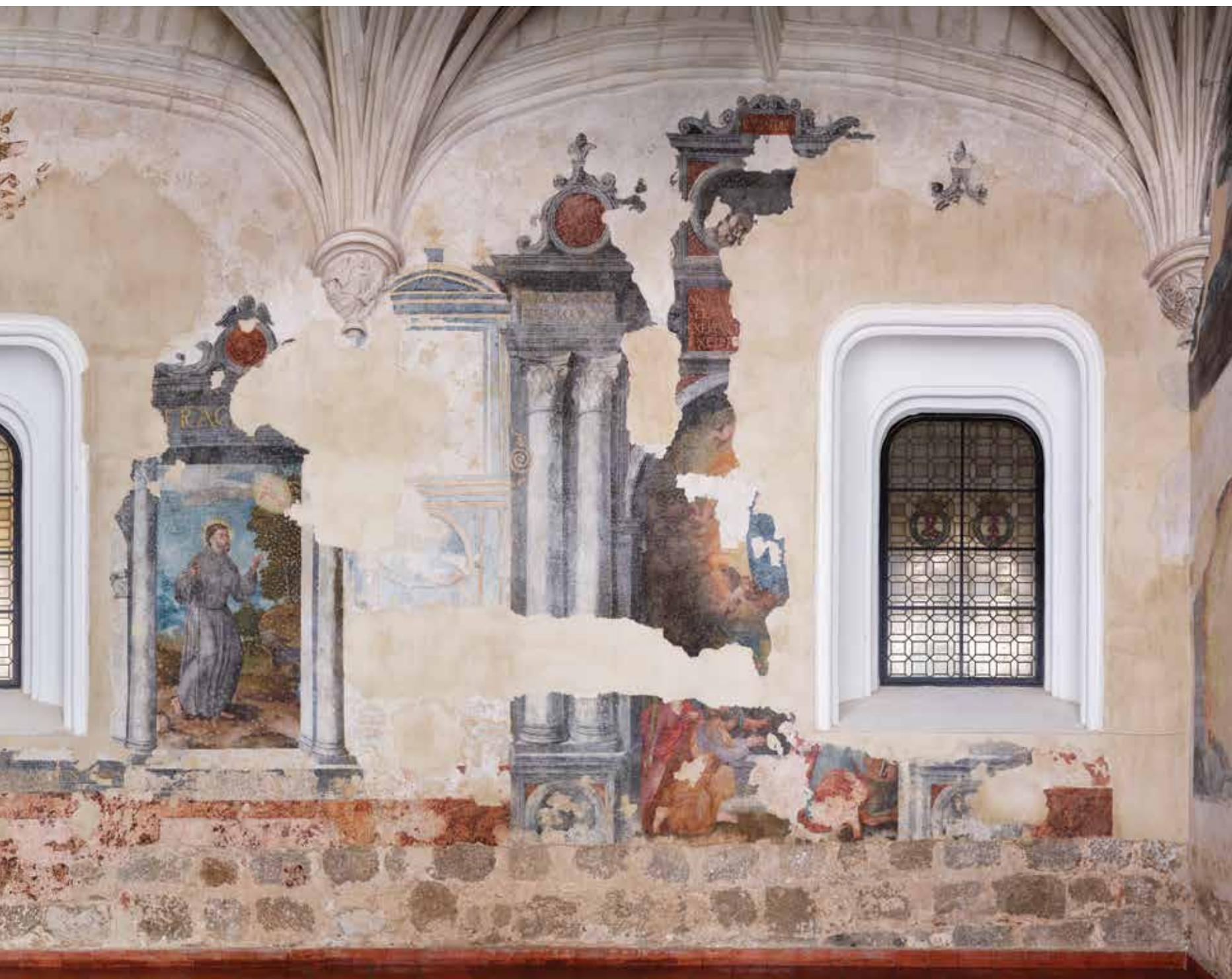
Muro oeste, antes y después de la restauración.
