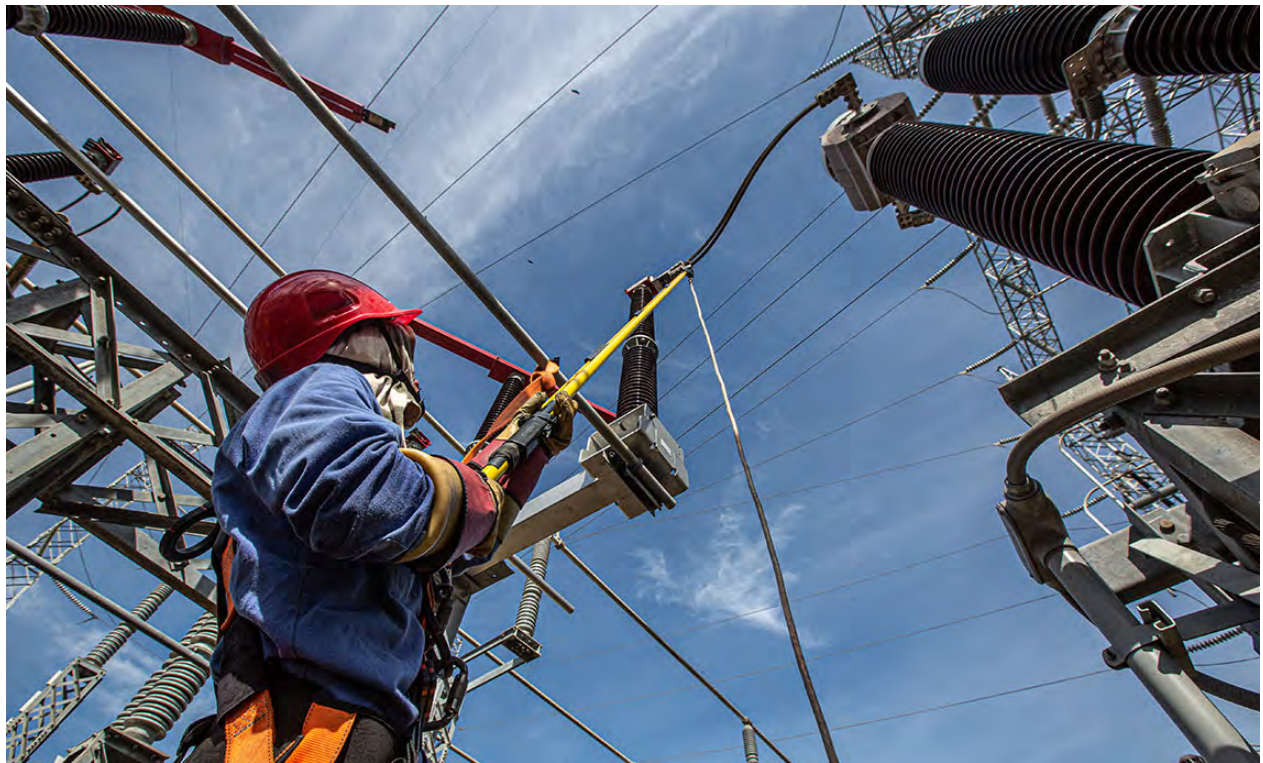
Colaborador en labor de mantenimiento, subestación Termocandelaria
