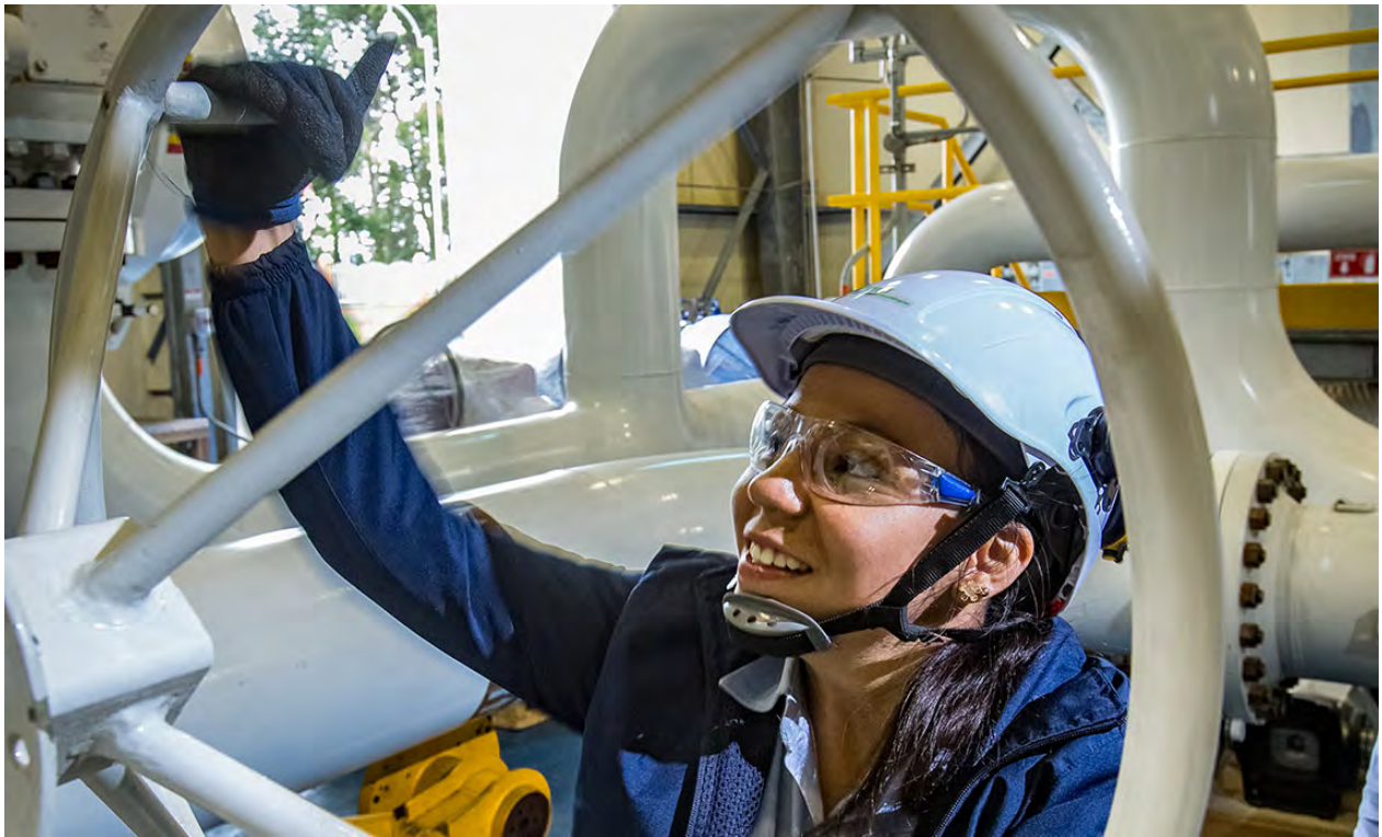
Colaboradora de nuestra compañía TGI en labores de inspección de equipos
