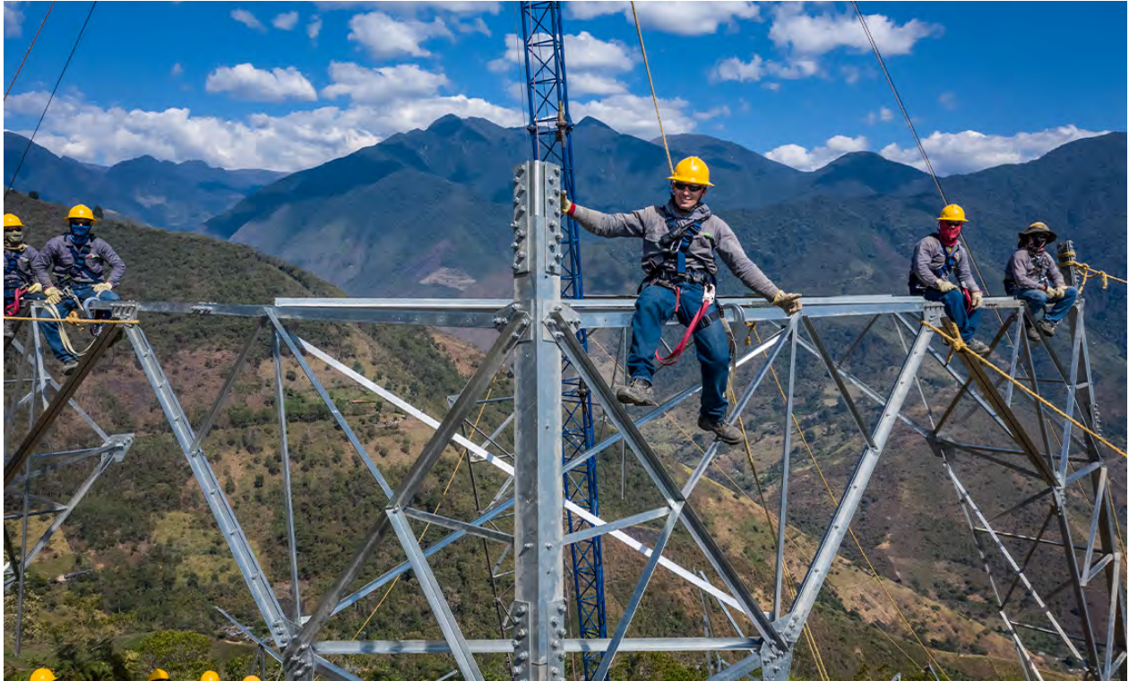
Construcción segundo tramo proyecto Tesalia - Alférez
