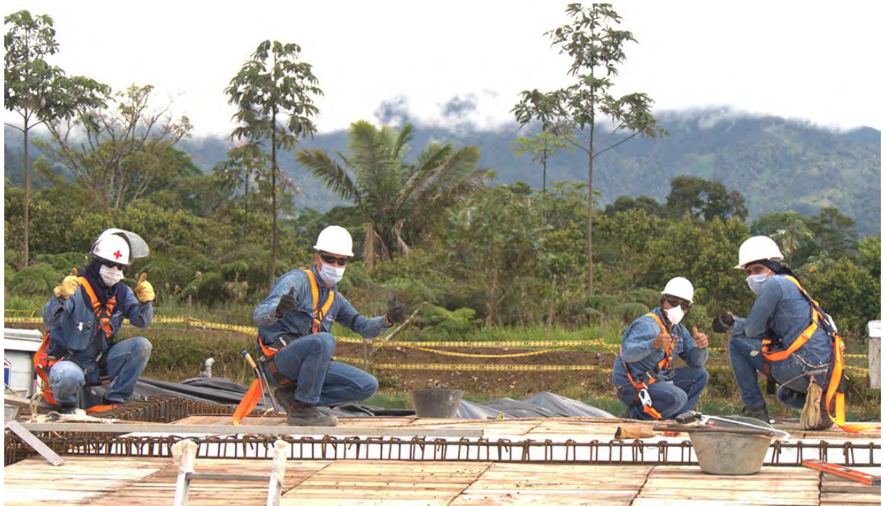
Contratistas de GEB en construcción y adecuación de la nueva subestación Renacer en Mocoa
