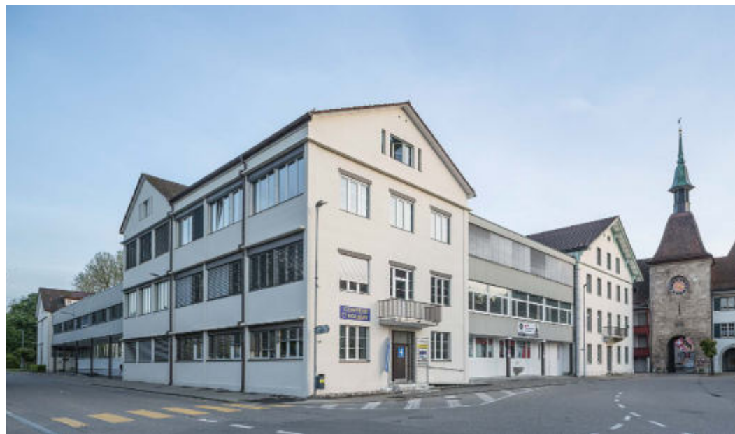
ABB. 300 Wangen a. A. Vorstadt 4. Textilfabrik Howald. Ansicht von Südosten. Links die Erweiterung von Alfred Roth , rechts der ehemalige Gasthof Rössli von 1868. Foto Markus Beyeler, 2016. KDP.
