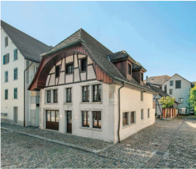
ABB. 266 Wangen a. A. Städtli 7. Ehemaliges Spital. Ansicht von Nordwesten. Die nach Norden gerichtete, 1821 erbaute Eingangsfassade mit Kalksteingliederungen weist einen mittensymmetrischen Aufbau auf. Zwillingfenster mit profilierten Fensterbänken in Karniesform flankieren die zentrale Eingangsachse. Der Türsturz mit dem Wangener Wappen und der Datierung 1821 ist identisch mit jenem am ehemaligen Rathaus (Städtli 20). Foto Beat Schertenleib, 2017. KDP.
