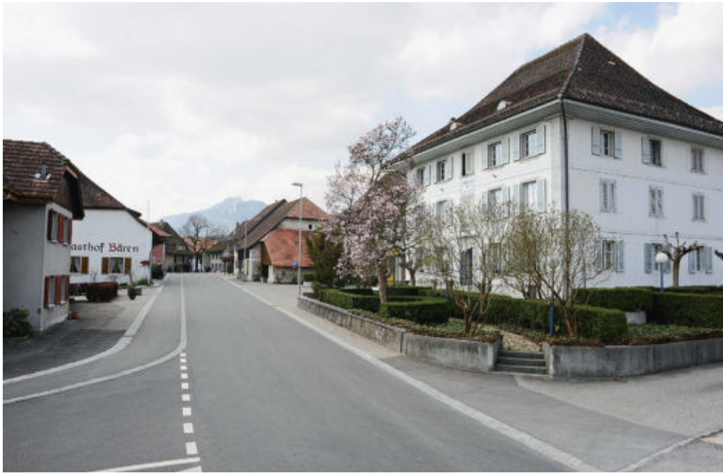
ABB. 142 Attiswil. Oltenstrasse von Osten. Der Eingang zum Dorfkern Attiswil ist geprägt vom Gasthof Bären (Oltenstrasse 4) und vom dreigeschossigen Doktorhaus (Oltenstrasse 5). Foto Beat Schertenleib, 2010. KDP.
