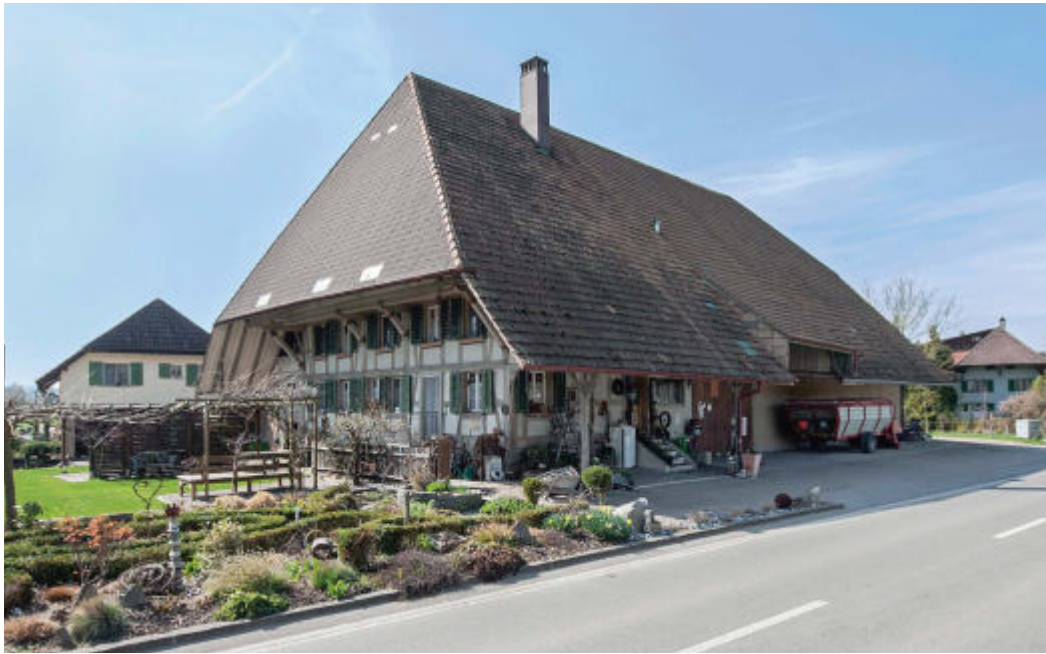
ABB. 454 Thörigen. Buchsistrasse 29. Bauernhaus von 1805. Ansicht von Südosten. Es ist ein typischer Vertreter des jüngeren Bauernhaustypus. Der Schild des Halbwalmdachs ist vor die Bühnslaube herabgezogen. Die aufwendige Konstruktion wird von langen und kurzen Bügen mit Diagonalrippenmotiv abgestützt. Anstelle einzelner Fensterverdachungen schliesst ein profiliertes Gesims das ganze Stubengeschoss ab. Foto Beat Schertenleib, 2017. KDP.
