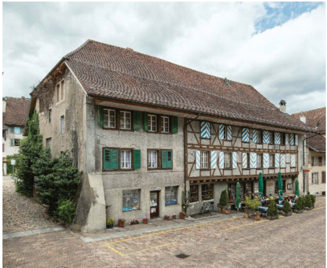
ABB. 108 Wiedlisbach. Städtli 6. Gasthaus Schlüssel. Ansicht von Südwesten. Der monumentale, langgezogene Baukörper unter abgewalmtem und geknicktem Satteldach setzt in der Hauptgasse einen wichtigen Akzent. Auffallend sind die mächtige Trauffassade mit unregelmässiger Befensterung, die vorkragende Konstruktion aus braunem Rieg und die neuzeitlich blau-weiss gestreiften Fensterläden. Foto Beat Schertenleib, 2017. KDP.
