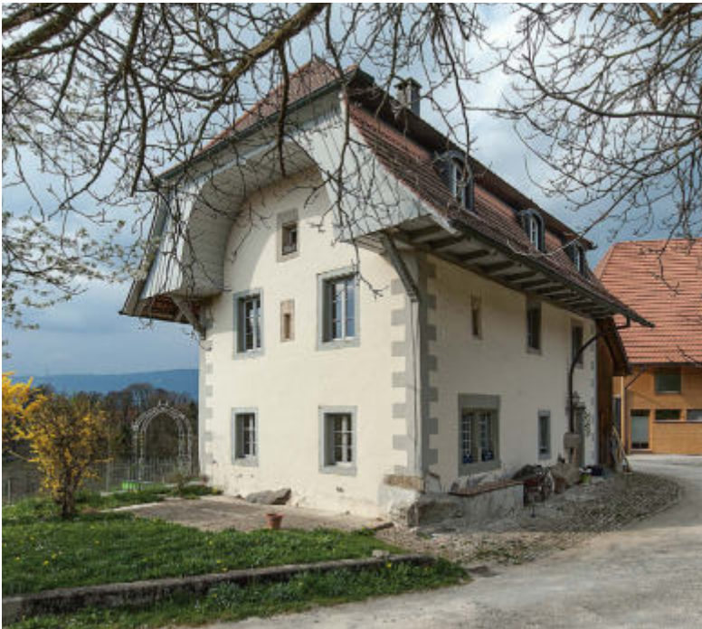
ABB. 390 Graben. Baumgarten 17. Wohnstock. Ansicht von Süden. Zum Kernbau von 1589 gehören die schmalen, schlitzförmigen Öffnungen. Beim Ausbau 1829 wurde das Gebäude um ein Drittel verlängert, neu befenstert und erhielt sein heutiges, markantes Mansarddach. Foto Beat Schertenleib, 2017. KDP.
