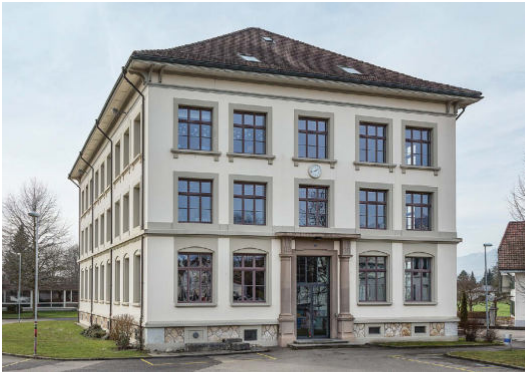
ABB. 304 Wangen a. A. Schulhausstrasse 5. Schulhaus. Ansicht von Osten. Die Erschliessung über das nordseitig angelegte Treppenhaus ermöglichte die Anordnung der Klassenzimmer mit möglichst vielen Fenstern gegen Süden. Foto Markus Beyeler, 2016. KDP.
