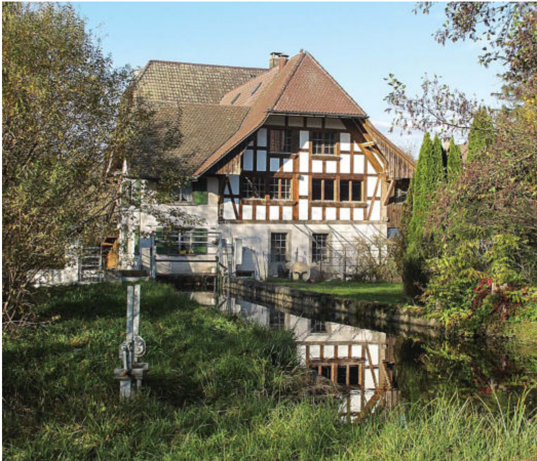
ABB. 419 Niederönz. Schlyffiweg 1. Obere Mühle. Ansicht von Süden. Vor der Mühle staut ein Wehr die Önz zu einem ruhigen Kanal auf. Die Schleuse im Vordergrund links regulierte den Ablauf in einen Wassergraben für die Wässermatten. Foto Ursula Schneeberger, 2015. KDP.
