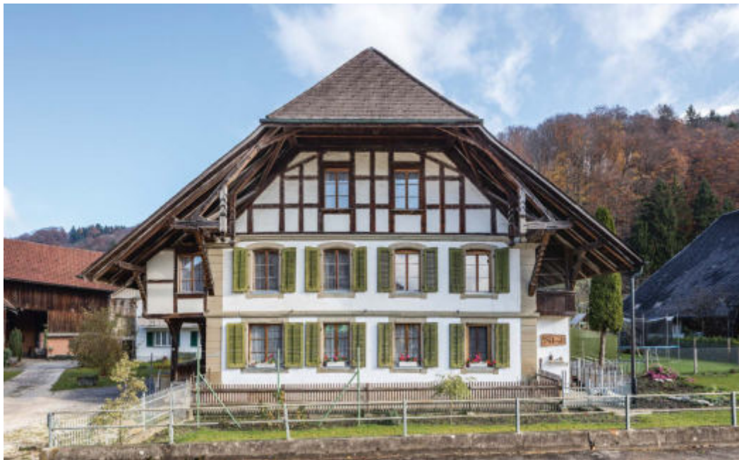
ABB. 499 Seeberg, Riedwil. Oschwandstrasse 1. Schmiedestock. Ansicht von Südwesten. Foto Markus Beyeler, 2017. KDP.
