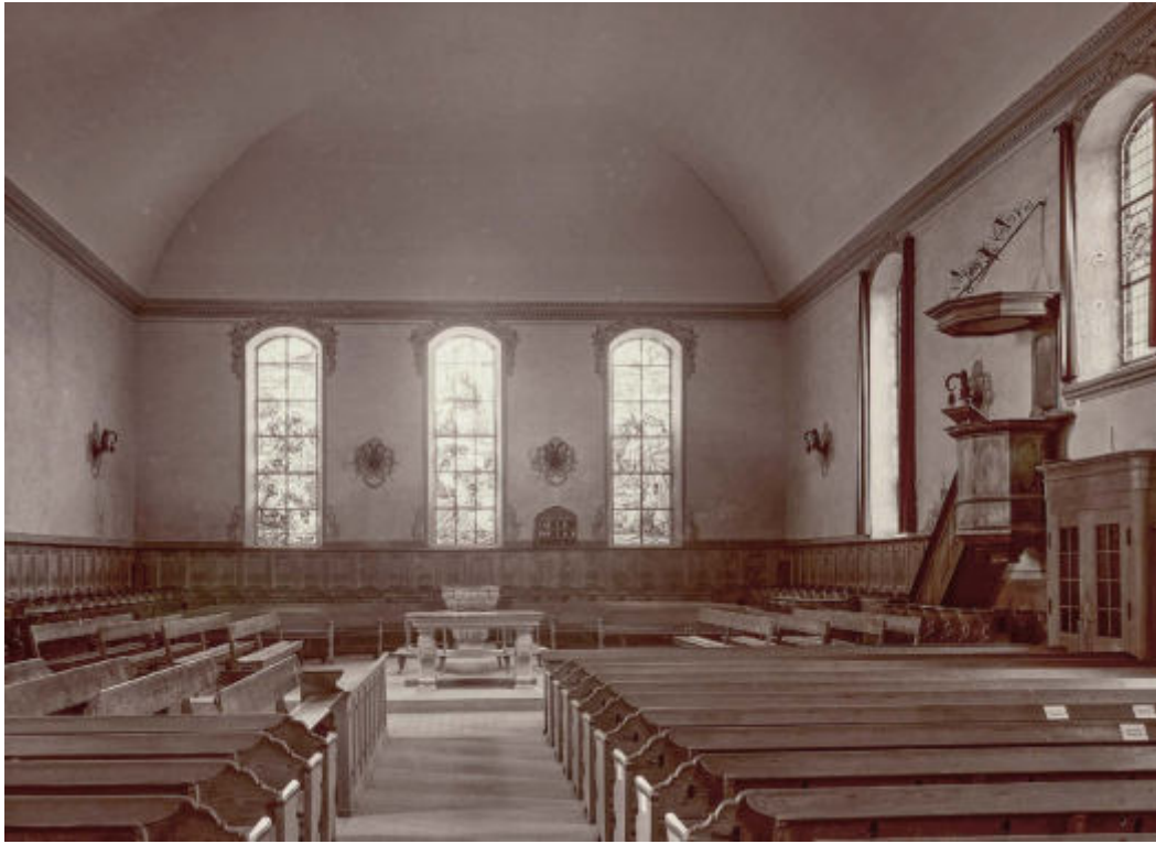
ABB. 343 Herzogenbuchsee. Kirchgasse 19. Reformierte Kirche. Innenraum nach Osten. Die Aufnahme entstand nach dem Einbau der Chorfenster von Eugène Burnand 1912 und vor der Neugestaltung des Innenraums 1920. Die Kanzel befindet sich noch an der Südwand. Abendmahlstisch und der Taufstein mit umlaufendem Kniebänklein sind in der Mittelachse angeordnet. Die Bänke im vorderen Schiffbereich sind zur Kanzel ausgerichtet. Foto vor 1920. KDP.
