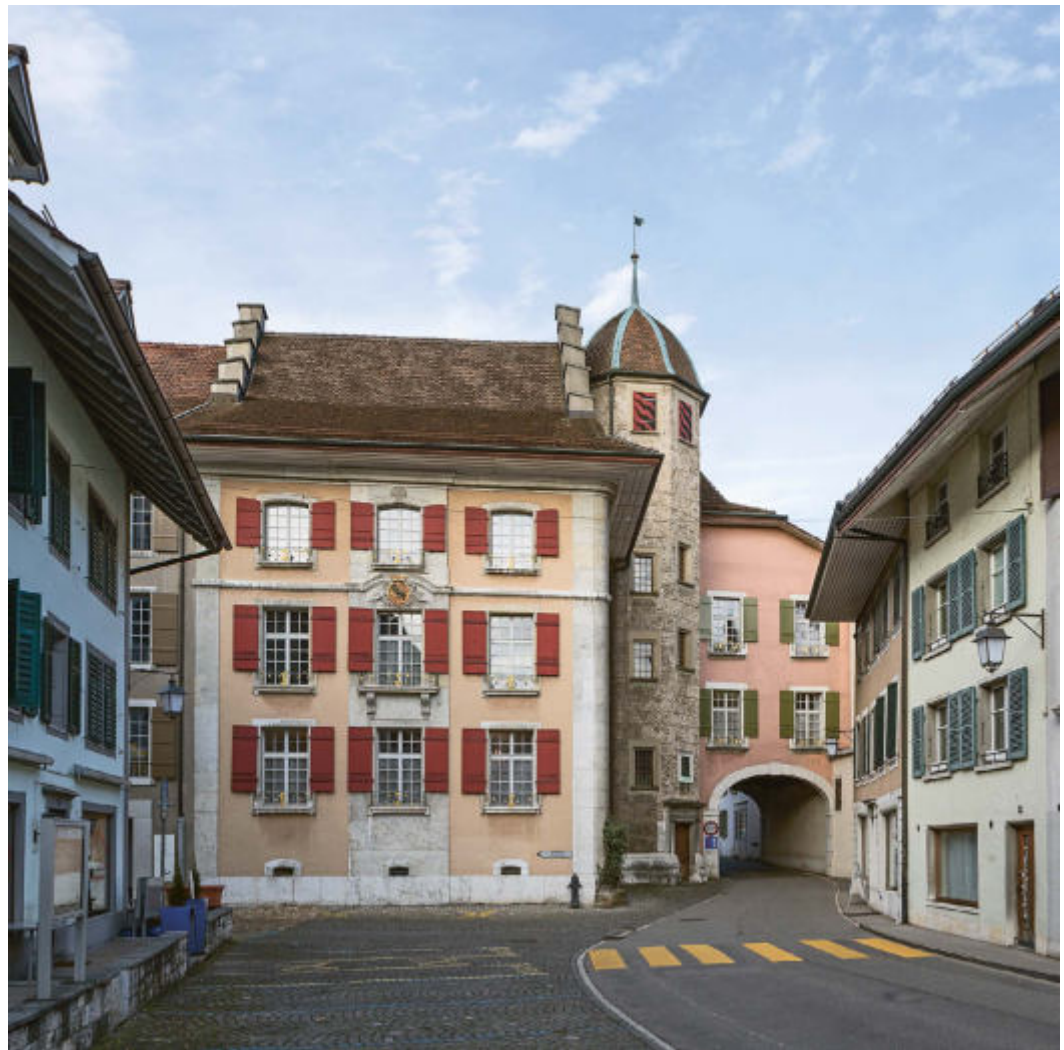
ABB. 208 Wangen a. A. Städtli 26. Schloss. Der Blick von Süden gewährt eine Übersicht auf die verschiedenen Trakte. Links im Bild die spätbarocke Südfassade von 1786–1787, die den älteren Hauptbau von 1561–1563 mit seinem sichtbaren Satteldach zwischen Treppengiebeln erweitert. Mittig der 1632 vollendete Treppenturm, rechts davon die Tordurchfahrt und die darüberliegenden Appartements. Foto Markus Beyeler, 2016. KDP.
