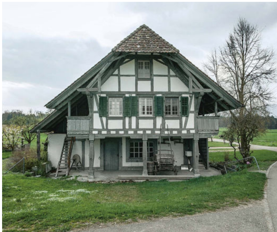
ABB. 397 Heimenhausen. Riedgasse 11. Ehemalige Schmiede. Ansicht von Osten. Ein selten gut erhaltenes Beispiel eines kleinen Gewerbegebäudes. Der überdeckte Vorplatz erlaubte das Arbeiten im Freien bei jedem Wetter. Über der Werkstatt befand sich eine kleine Wohnung. Foto Beat Schertenleib, 2017. KDP.
