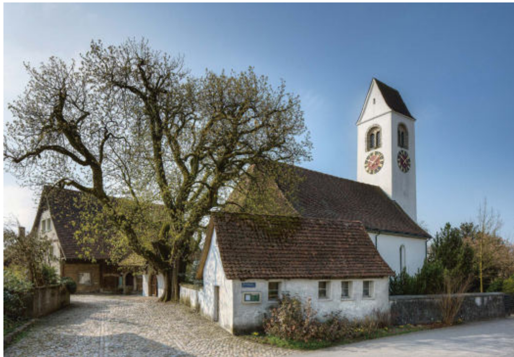
ABB. 172 Niederbipp. Kirchgasse 15. Reformierte Kirche. Ansicht von Nordosten. Kirche, Kirchhofmauer, ehemaliges Waschhaus und der Kastanienbaum bilden einen intimen Hofraum, der vom sogenannten Sigristenhaus hinten räumlich gefasst wird. Foto Markus Beyeler, 2010. KDP.
