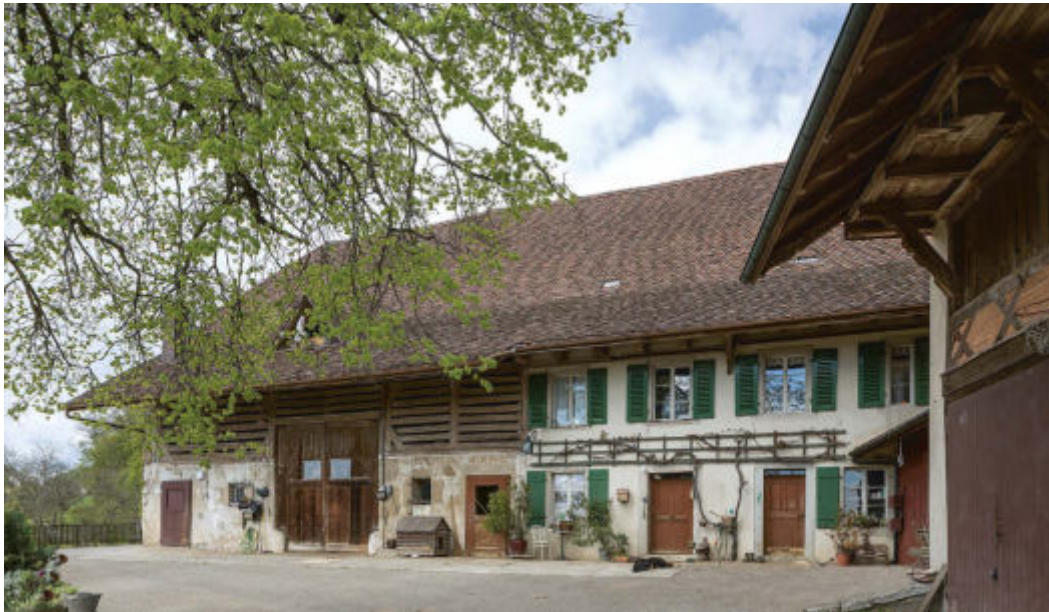
ABB. 48 Oberbipp. Schlossstrasse 30. Gutshaus. Ansicht von Süd-osten. Das Gutshaus bildet zusammen mit der abgewinkelt dazu angebauten Remise den Kern des Gutshofs. Foto Markus Beyeler, 2016. KDP.
