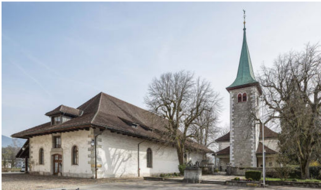
ABB. 283 Wangen a. A. Weihergasse 10. Neues Salzhaus. Ansicht von Südwesten. Das Gebäude steht an der Stelle des Gartens und der Matte des während der Errichtung 1775 amtierenden Landvogts Albrecht Anton Imhof . Foto Markus Beyeler, 2016. KDP.
