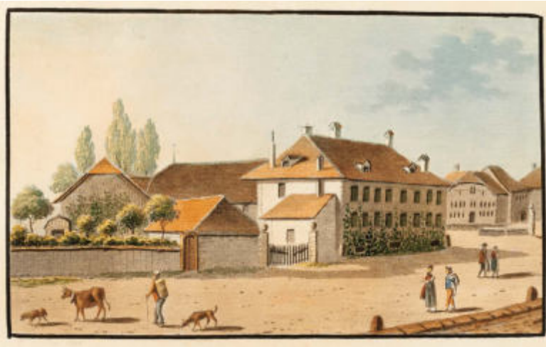
ABB. 346 Herzogenbuchsee. Bernstrasse 2. Ehemaliges Doppelpfarrhaus. Ansicht von Südwesten. Jakob Samuel Weibel, 1825, Aquatinta. Die Strassenfassade zeigt noch die regelmässige Befensterung mit der Blendfensterachse. An der Westfassade befand sich ein angebautes Waschhaus mit Pultdach. Im Vordergrund sind die Rückseite eines Holzschopfs und dahinter die Dächer der 1864 abgebrannten Pfrundscheune und des Kornhauses sichtbar. (NB Graphische Sammlung, Slg. Gugelmann). Foto NB.
