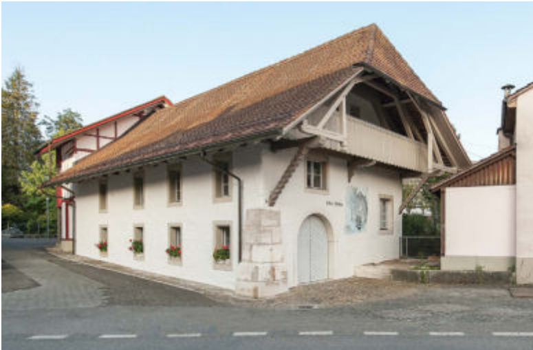
ABB. 284 Wangen a. A. Weihergasse 10. Neues Salzhaus. Aufriss der Ostfassade der am 7.4.1775 genehmigten Fassadenpläne von Niklaus Hebler. Sockel, Eckquader, Tür- und Fenstereinfassungen aus Solothurner Kalkstein gliedern das verputzte Mauerwerk. Über den
