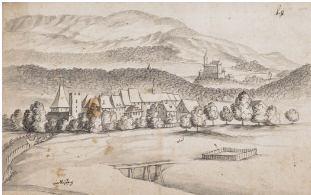
ABB. 102 Wiedlisbach. Ansicht des Städtchens von Süden. Anonymus Falkeisen, wohl nach 1716. Im Hintergrund Schloss Bipp. Nachdem die südliche Ringmauer ihre Funktion als Wehrmauer verloren hatte, wurde sie mit Fenstern durchbrochen. Die nach Süden orientierten Lauben dürften erst im 19. Jh. ergänzt worden sein. (KUKABS). Foto KUKABS.
