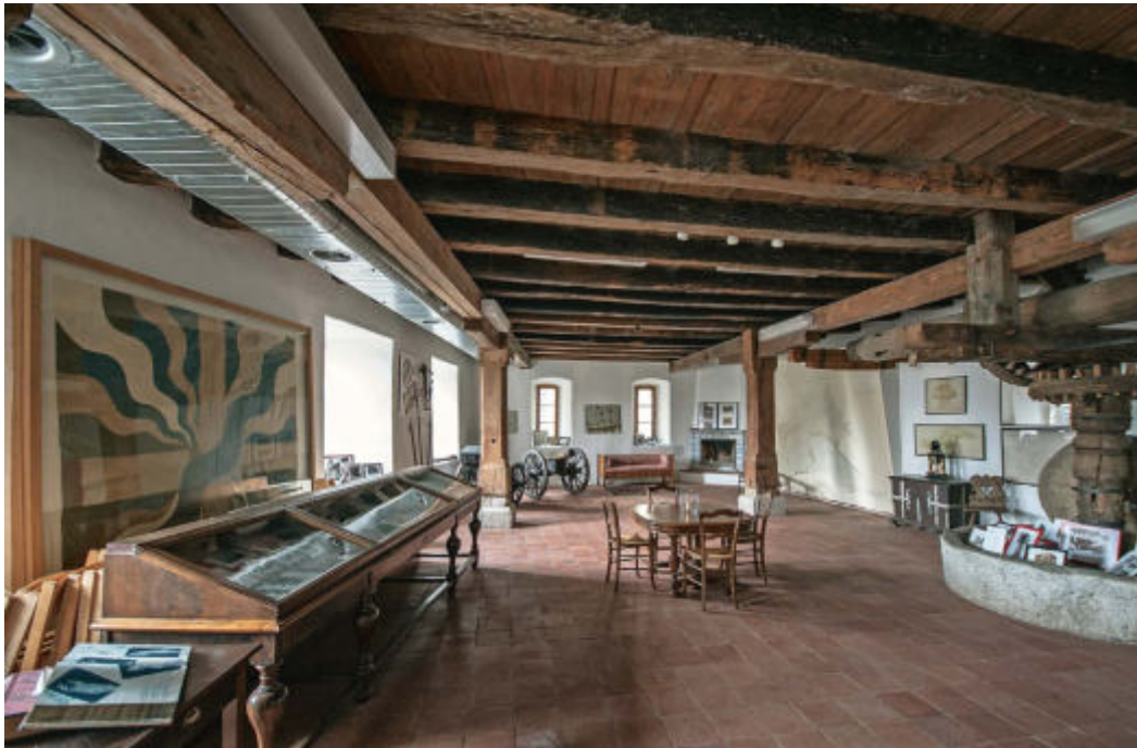
ABB. 101 Wiedlisbach. Städtli 20. Ehemaliges Kornhaus. Erdgeschoss gegen Norden. Vier massive Holzpfosten mit Sattelhölzern und Unterzügen gliedern die halbenartiges Geschosse; bis ins Dachgeschoss bildet diese Konstruktionsweise eine Struktur von hoher Tragfähigkeit. Foto Beat Schertenleib, 2016. KDP.
