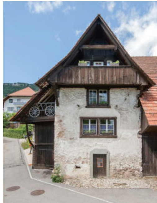
ABB. 162 Rumisberg. Unterer Winkel 1. Gemauerter Wohnstock aus der frühen Neuzeit. Der Dachstuhl und die gemalten Ecklisenen stammen von 1760, der ostseitige Ökonomietrakt wurde im 19. Jh. angebaut. Foto Beat Schertenleib, 2017. KDP.
