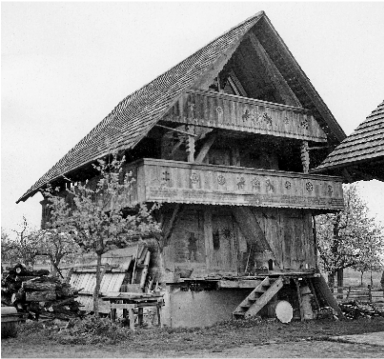
ABB. 406 Inkwil. Wangenriedstrasse 8b. Speicher von 1740. Ansicht von Süden. Der Ständerbau-speicher zehn Jahre nach der Renovation durch Walter Soom. Foto Martin Hesse, 1961. KDP.
