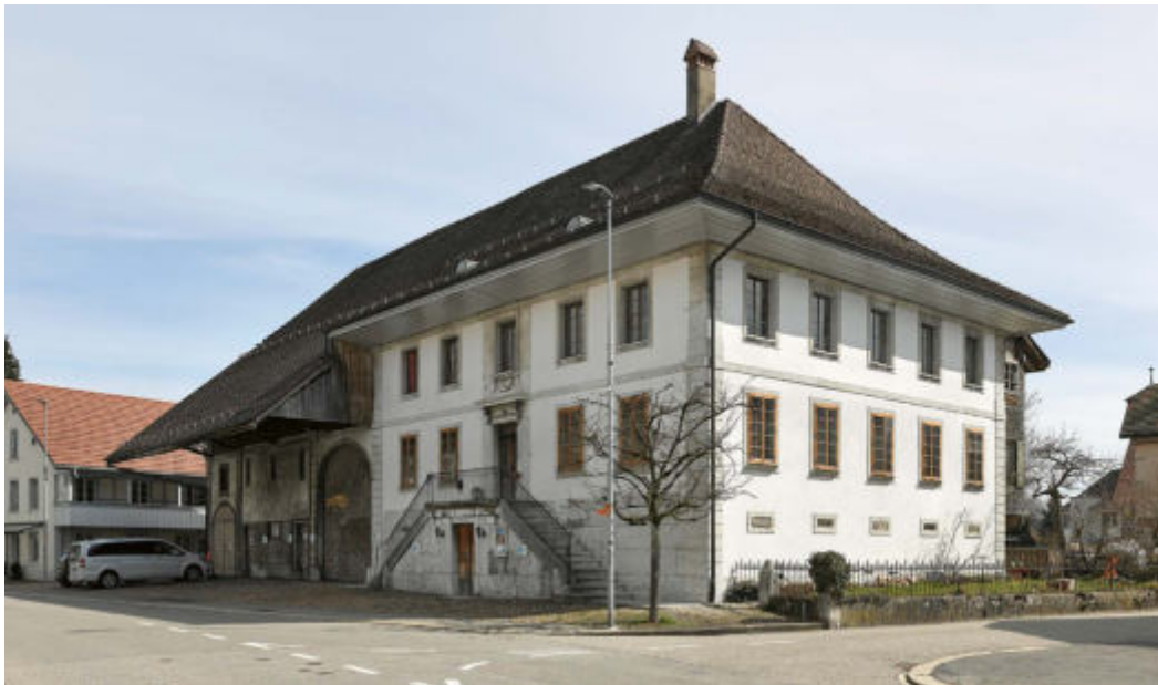
ABB. 301 Wangen a. A. Vorstadt 15/17. Wohnstock von Südwesten mit ein-drucksvollen Hausteingliederungen und den reich befensterten Fassaden. Das mächtige, sanft gekrümmte Vollwalmdach ist über dem Ökonomieteil tiefer herabgezogen, so dass vor den Eingängen zur Scheune ein grosszügiger Vorscherm entsteht. Foto Dirk Weiss, 2018. GSK.
