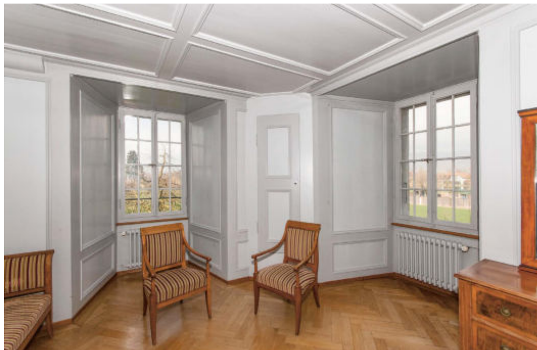
ABB. 263 Wangen a. A. Städtli 40. Pfarrhaus. Nordwestliches Täferzimmer im 1. Obergeschoss, 18. oder 19. Jh. Die Eigenart des Täfers ist bedingt durch die massiven Grundrissmauern, die zu auffallend tiefen Gewändezonen führen. Foto Beat Schertenleib, 2016. KDP.
