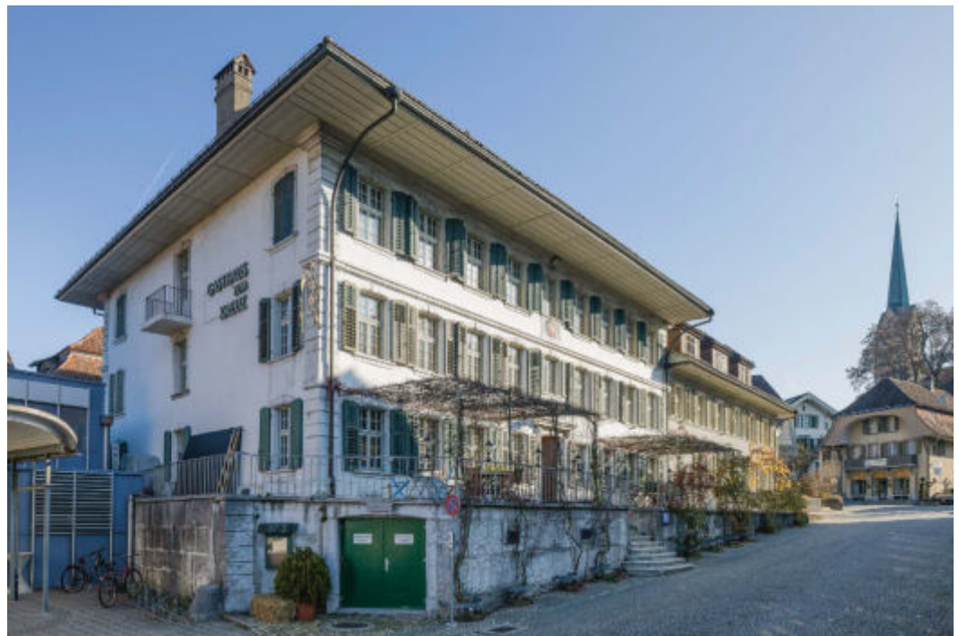
ABB. 350 Herzogenbuchsee. Kirchgasse 1. Gasthof Kreuz von 1787. Der imposante Bau mit seiner Fassade aus Solothurner Kalkstein steht auf einem massiven Kellersockel, der eine Terrasse ausbildet. Foto Markus Beyeler, 2011. KDP.
