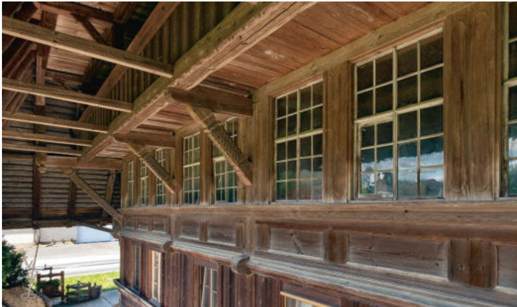
ABB. 407 Inkwil. Bahnhofstrasse 1. Bauernhaus von 1821. Ansicht von Süden. Der Walmdachschild ist nur wenig zurückgeschnitten und gibt den Blick frei auf das original erhaltene Gadengeschoss mit ungewöhnlich grosszügiger Befensterung. Nur schmale Pfosten mit Reliefschnitzerei trennen die Fenster mit 20er-Teilung. Sie setzen sich optisch in der Felderteilung der Brüstungszone unterhalb der durchlaufenden Fensterbank fort. Foto Beat Schertenleib, 2017. KDP.
