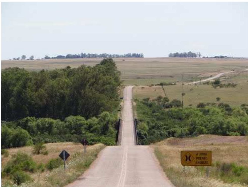
Figura 2.2 Puente sobre ruta 31, 150 m aguas abajo del sitio del emprendimiento.
