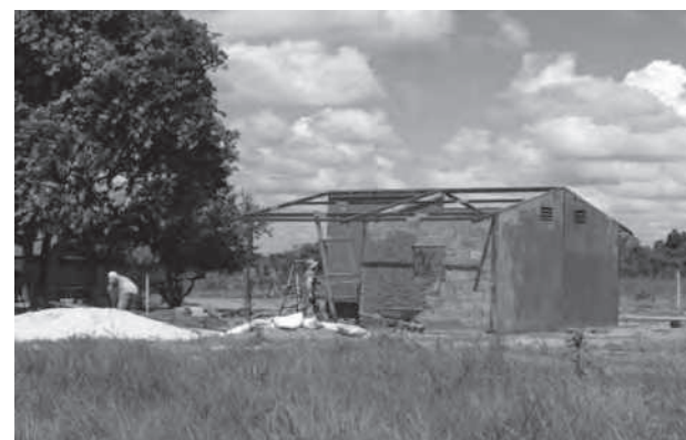
Fotografía 9. Construcción de nuevas casas en la comunidad El Calvario. Pueblo Yaruro
